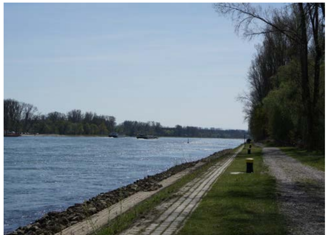
Abb. 53. Von der Jetski-Rampe aus kann ein kleiner Rundweg begangen werden, vorbei am Obelisk und an der Pegelmessstelle Leimersheim
