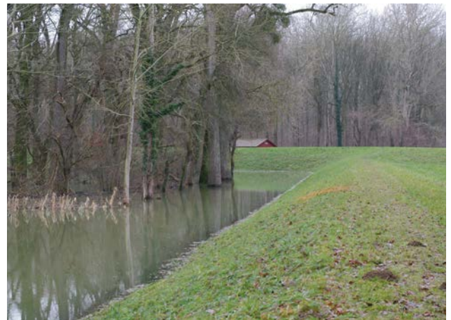
Abb. 37. Im Hochwasserfall stehen die Auwälder vor dem Steinholzdeich komplett unter Wasser. Auf dem Bild läuft an der Gemarkungsgrenze Leimersheim der Steinholzdeich an den höheren Rheinhauptdeich heran.
