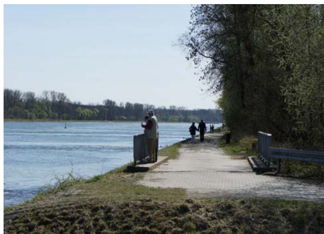
Abb. 54. Weiter südlich, im Bereich des Fähranlegers, wird der Leinpfad nochmals unterbrochen. Drei Rampen in den Rhein mit Zufahrtsbereichen lassen die Wegeverbindung nach Westen verschwenken. Südlich der dritten Rampe – hier im Bild – befindet sich eine Brücke über eine Schwelle, über welche bei erhöhtem Wasserstand Wasser in den Auwald einströmen kann.
