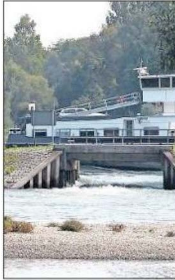
An dieser Stelle bei Leimersheim hat der Rhein schon eine Verbindung zum Altrhein. FOTO: VAN
