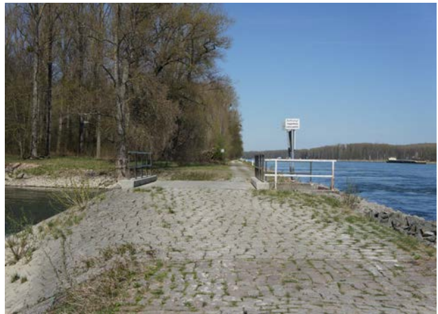
Abb. 13. Das neue Einlaufbauwerk am Leimersheimer Altrhein musste auch entsprechend den Anforderungen an den Leinpfad der Wasser- und Schifffahrtsverwaltung des Bundes ausgebaut werden, damit er wieder als Zufahrt auch für die Forstverwaltung genutzt werden kann.
