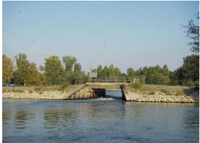
Abb. 12. Neues vergrößertes Einlaufbauwerk, die sogenannte Ingestion am Leimersheimer Altrhein. Um auch bei Niedrigwasser kontinuierliche Strömungsverhältnisse zu ermöglichen, wurde der Zufluss auf eine Sohlhöhe von ca. 1,0 m unter dem Mittleren Niedrigwasser (MNW) gelegt.
