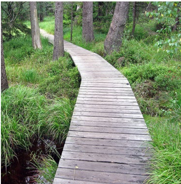
Abb. 100. Beispiel eines bodennahen, einfachen Holzsteiges über feuchte Senken
