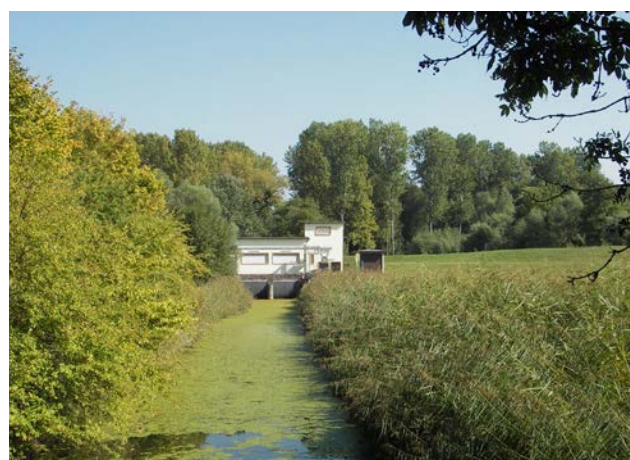
Abb. 09. Das Schöpfwerk ist mit dem Fischmal über einen Kanal verbunden, welcher im Sommer stark veralgt ist. Das Schöpfwerk muss im Zuge der Deichausbaumaßnahmen erneuert werden, insofern der Reserveraum Hördt ausgebaut wird.
