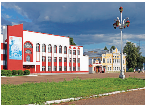
Здание районной администрации
