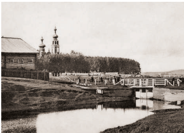
Мост через р. Ершовку
