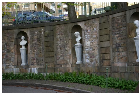
Delar av Piperska muren från 1702
