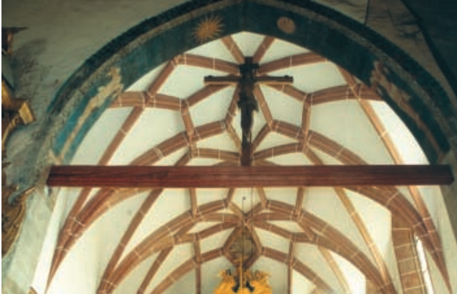
Gwiazdźisto-sieciowe sklepienie w prezbiterium kościoła farnego. Starnet-shaped vault in the presbytery of Parish Church.
