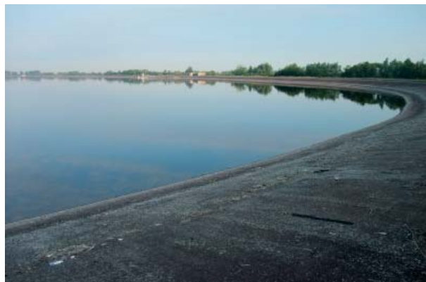
Rust bij Spaarbekken Honderd en Dertig. (Foto: Roy Slaterus)
