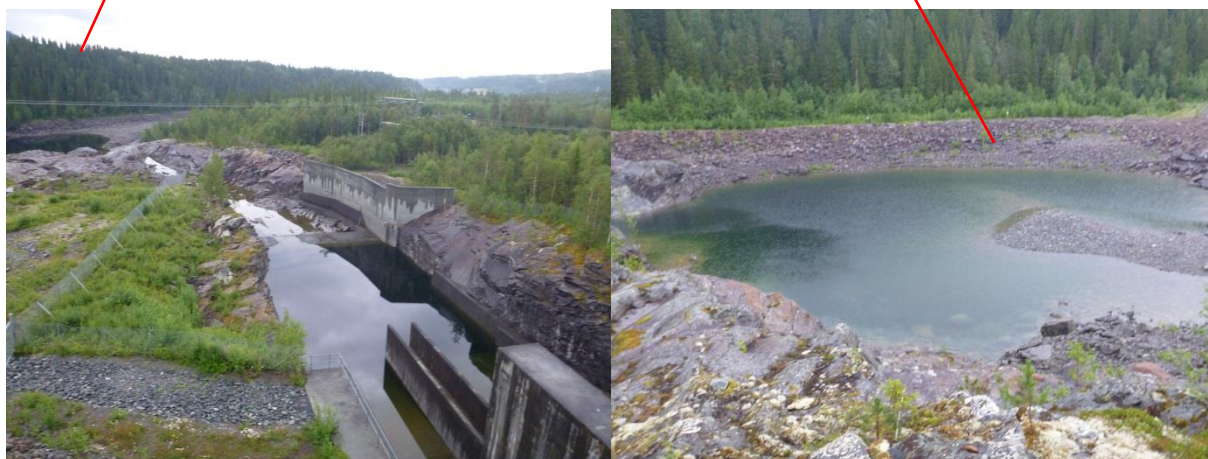
Figur 26 .Vänster: Vy från Gardikens kraftverk. Höger: Bassäng nedströms kraftverket
