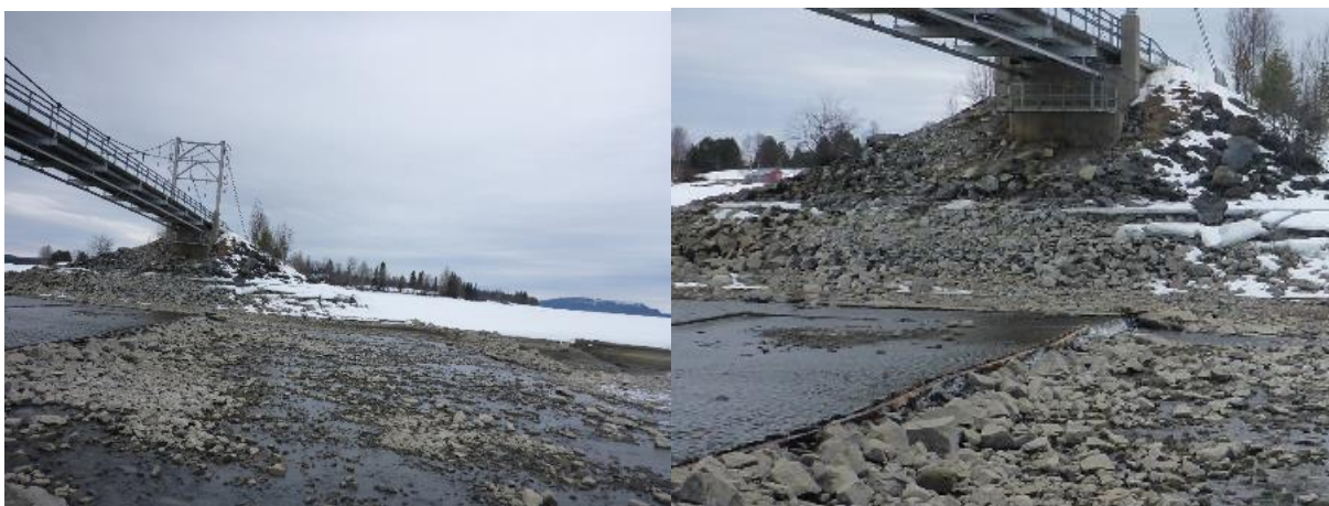
Figur 12. Vänster. Torrläggning ut mot Storuman sjön vid bron mot Kaskeloukt. Höger. Damm mot Storuman.
