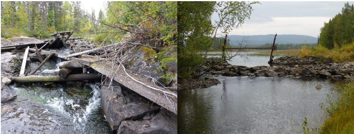
Figur 8. Vänster: Rester av Kvarn som utgör partiellt vandringshinder. Höger: damm som utgör partiellt hinder
