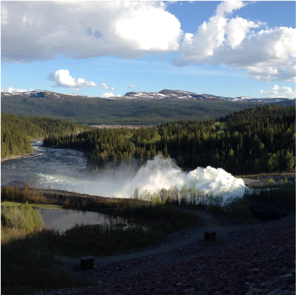
Figur 41. Torrfåran nedströms Ajaure kraftverk vid spill.
