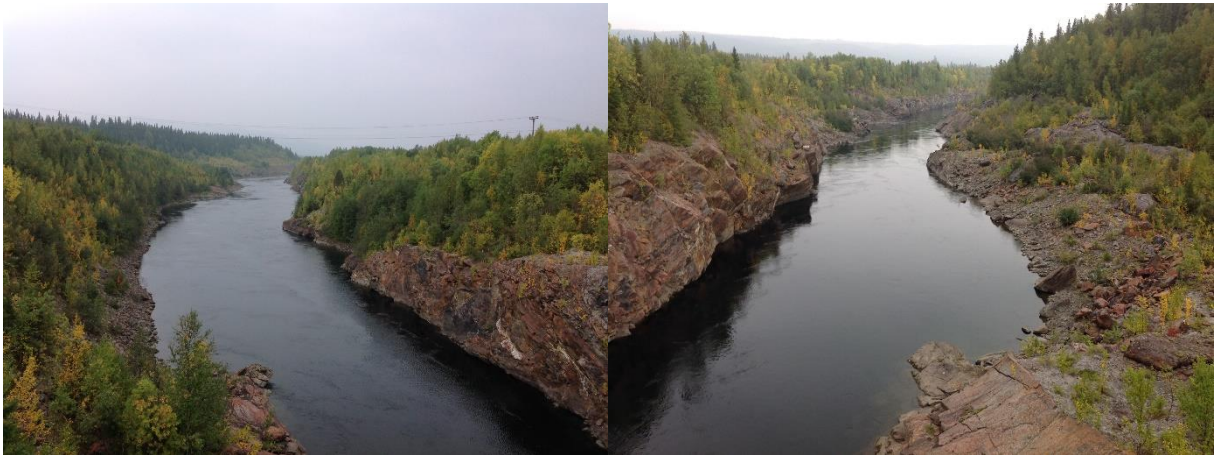
Figur 28. Utloppskanalen från Gardikens kraftverk
