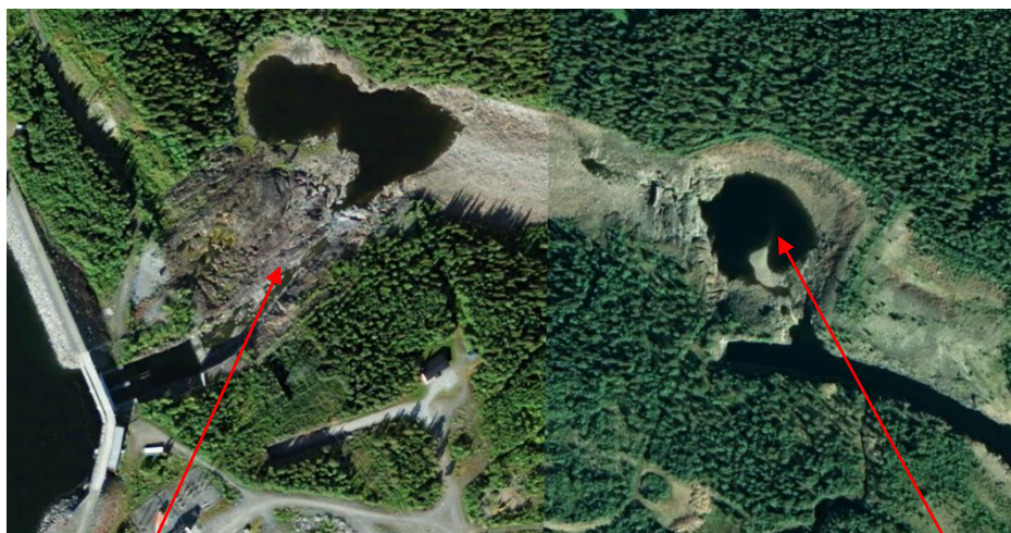
Figur 25. Ortofoto av torråran samt inledningen av utloppskanalen.
