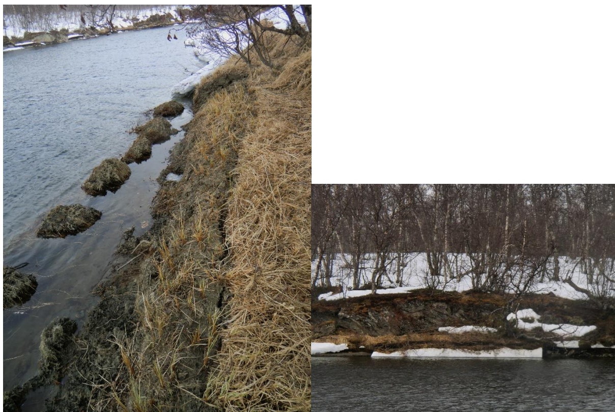
Figur 85. 2010-06-09 Vänster: Umeälven område 7 Nedre båtplats. Samma ställe som ovanstående bild. Slamavlagringen har blivit bredare och tjockare. Höger: 2014-05-07. Umeälven område 7 Nedre båtplats. På södra sidan älven (mitt emot båtplatsen) har strandkanten brutits loss.
