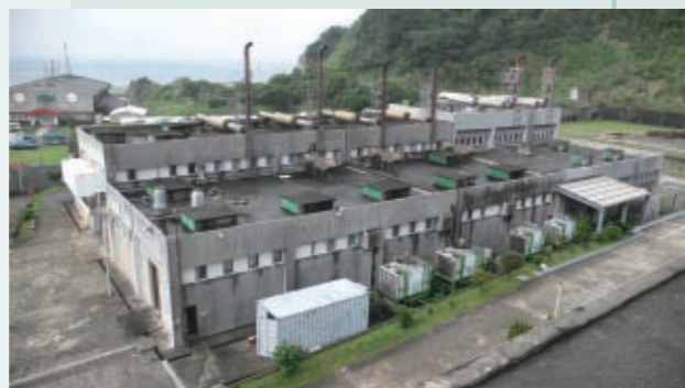
▲ 蘭嶼發電廠的廠房外景。
