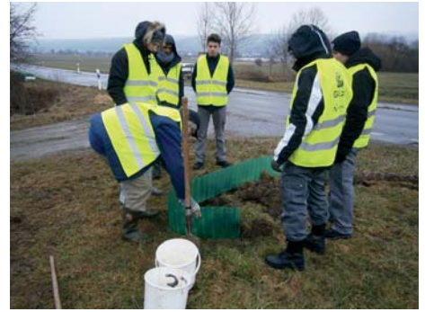
Montage von Amphibien-Schutzzäunen
