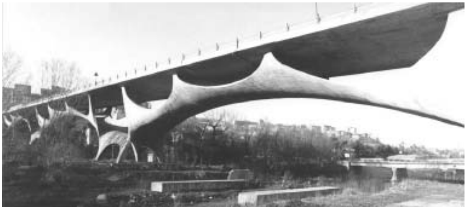
Fig. 1 – Vista di tre arcate del ponte
