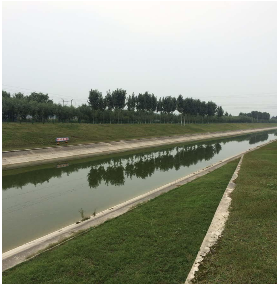
图 5.4-2 拟建项目跨越济平干渠处现状图
