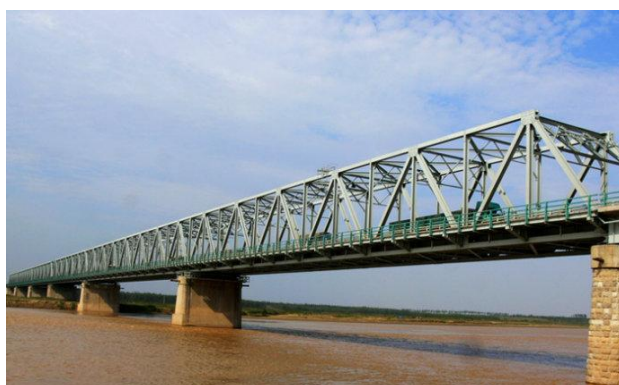
图 3.2-2 平阴黄河公路大桥
