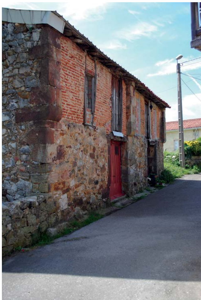
Barrio de La Riva. Dos casas con solana de ladrillo
