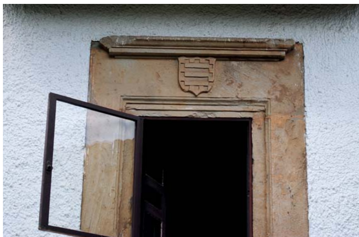
Escudo de los Ceballos. Fachada este del edificio anexo
