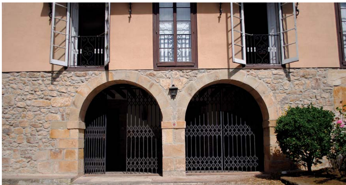
Arcos de medio punto en la fachada principal
