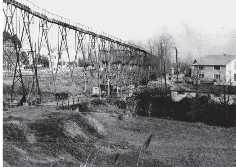
Canalón de fangos a Morero y compuertas del embalse natural de Solía
