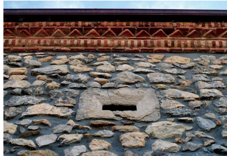
Ventana en forma de buzón de la fachada norte
