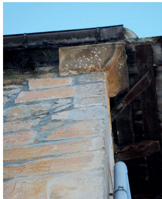
Restos de la portada de la capilla anexa a la torre y un alero y una esquina con piedras reutilizadas
