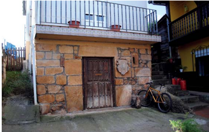
Puerta con dintel clásico y ventana en buzón
