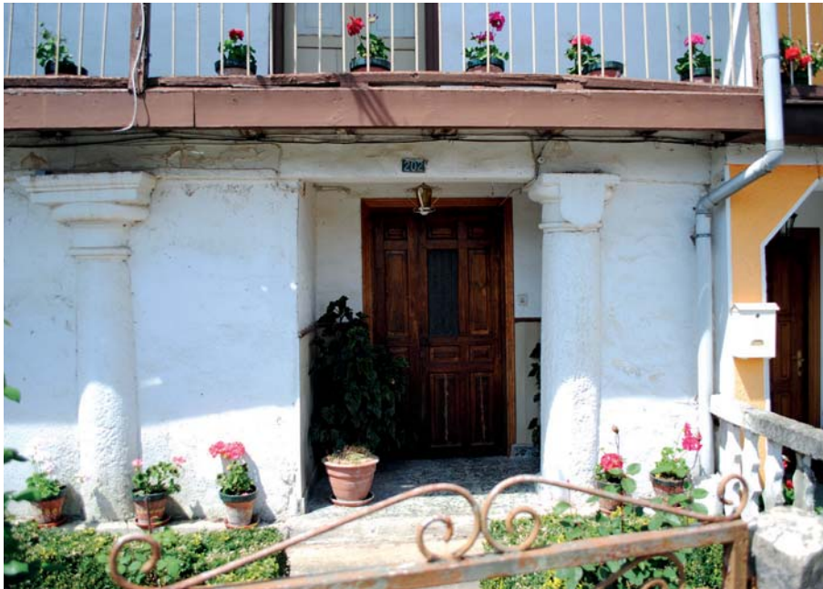
Barrio El Carmen. Soportal con dos columnas clásicas con capiteles toscanos, el de la derecha con placa de escudo sin labrar
