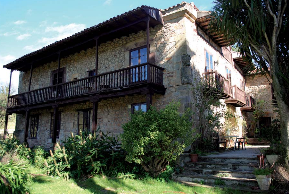
Vista de la fachada oeste
