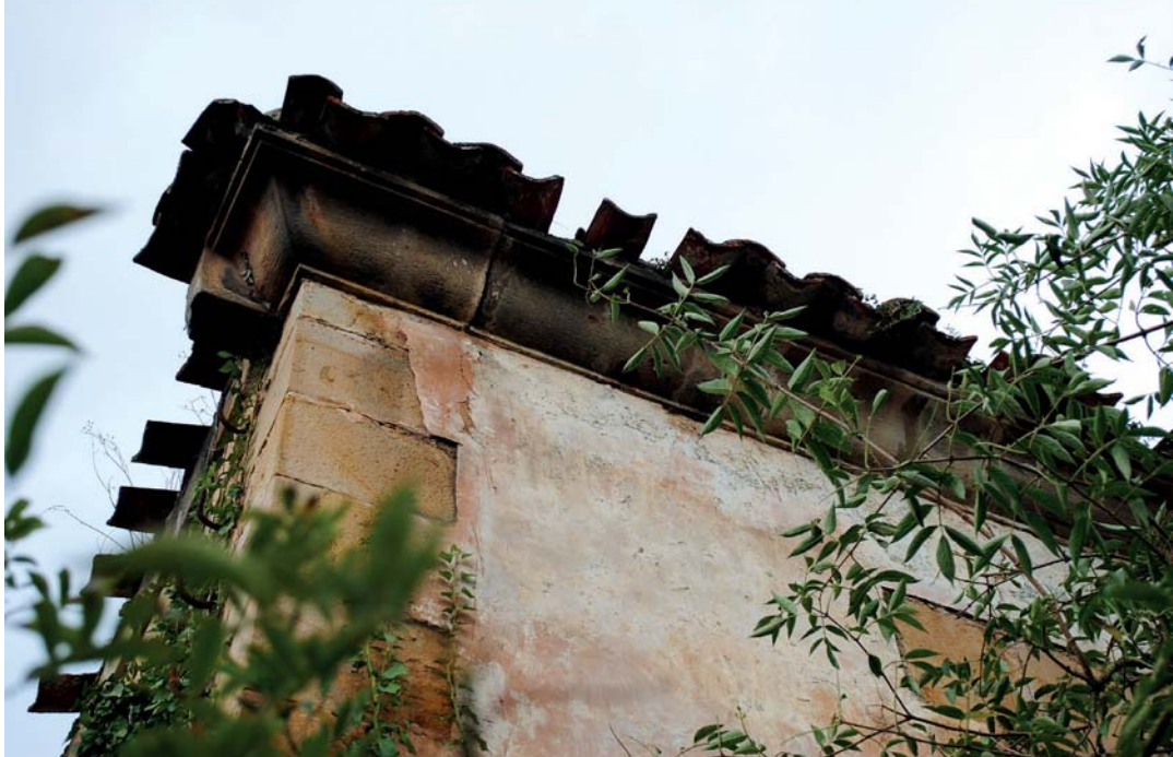
Detalle de la cornisa elaborada en piedra arenisca con forma de pecho de paloma
