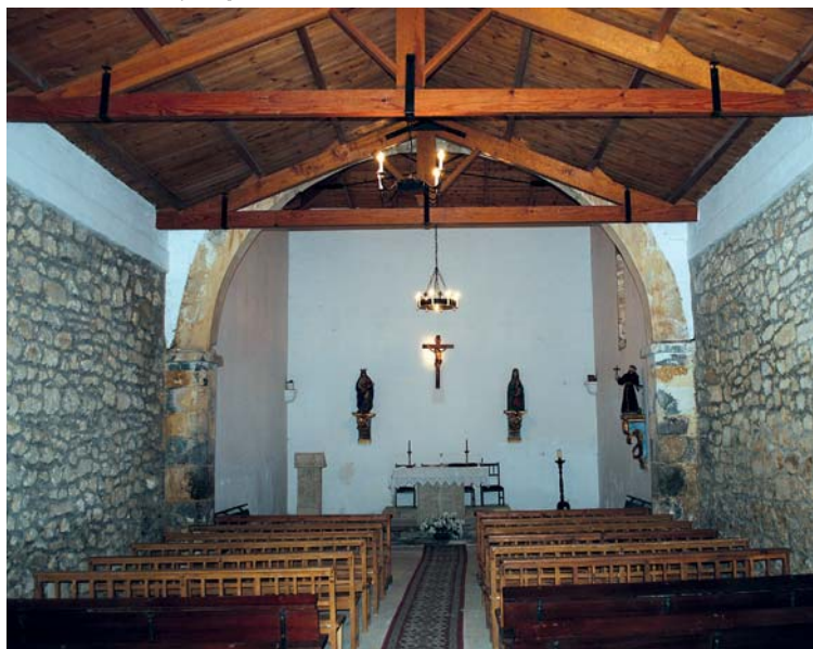
Vista de la nave y el presbiterio
