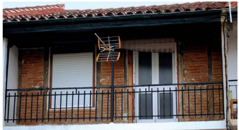
Solana de entramado en la vivienda central
