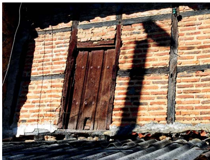
Fachada en entramado de madera y ladrillo (Liaño)
