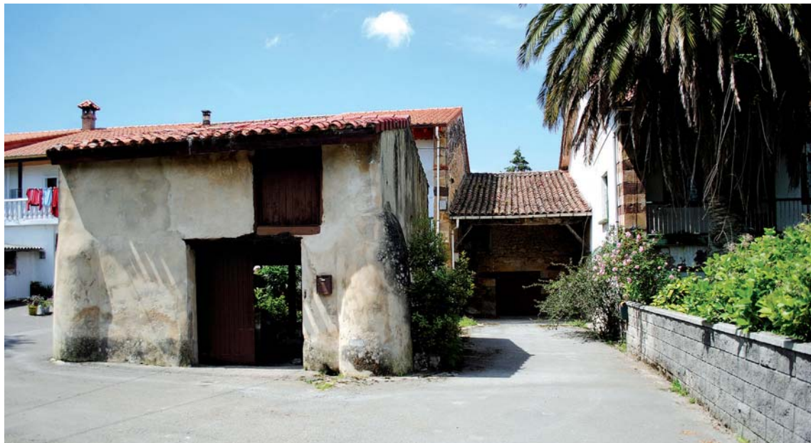
Barrio La Hoya. En primer plano, casa con «cuarto alto» protegida por pilares circulares. Al fondo, una cuadra-pajar, uno de los edificios más antiguos de Liaño
