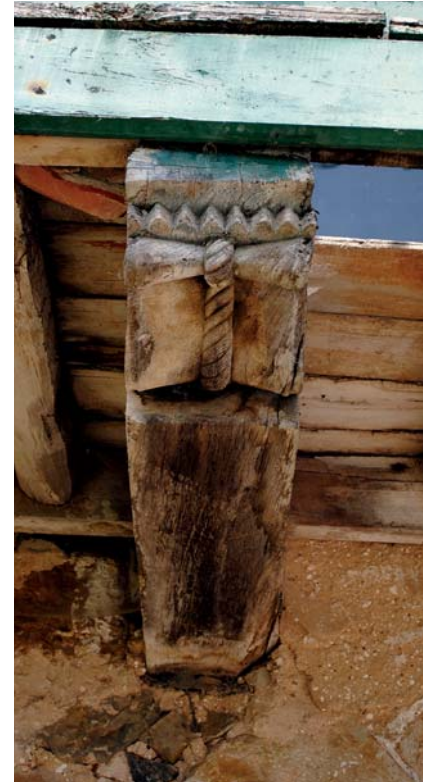
Detalle de una ménsula
