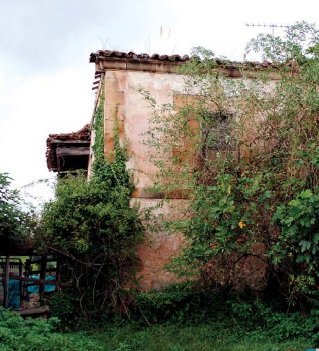
Vista de la cara este
