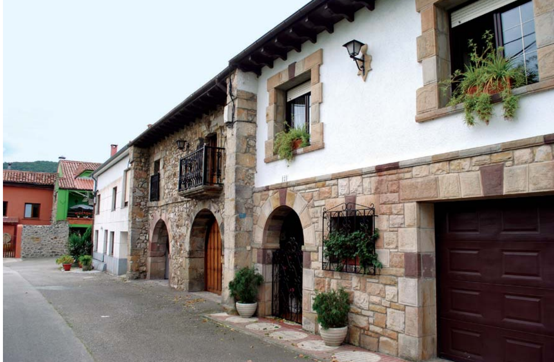
Barrio Merecía/La Iglesia. Casas adosadas. En el centro, el edificio del antiguo Ayuntamiento
