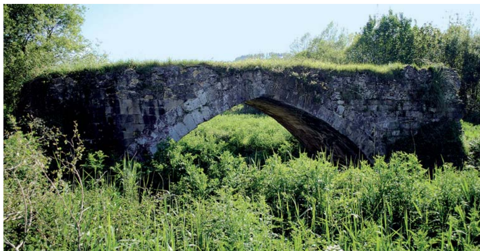
Dos vistas del estado actual del puente de Solía
