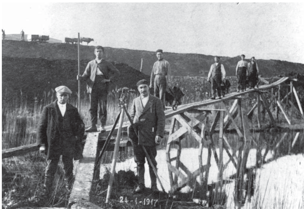
Trabajos topográficos en la sierra de Cabarga para hacer el trazado de las futuras vías por las que las vagonetas trasladarían el mineral de hierro. Al fondo se aprecia los carros de bueyes. 24 de enero de 1917.
