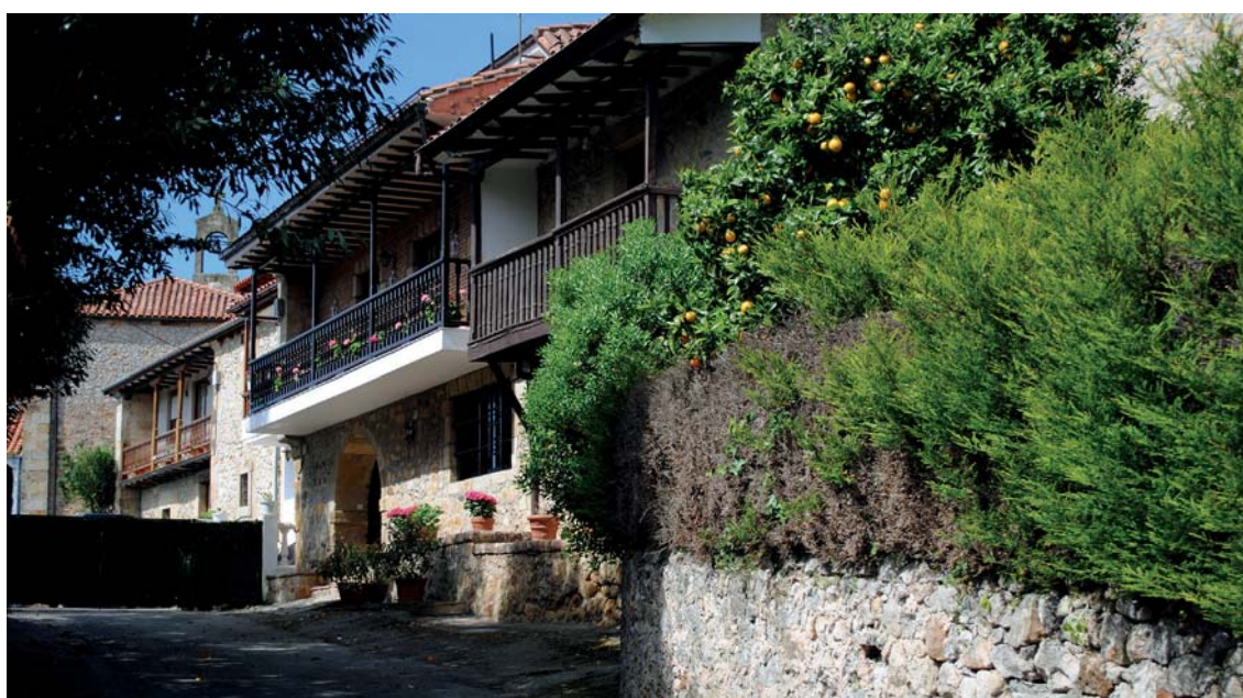
Barrio Merecía/La Iglesia. Otro conjunto de casas adosadas
