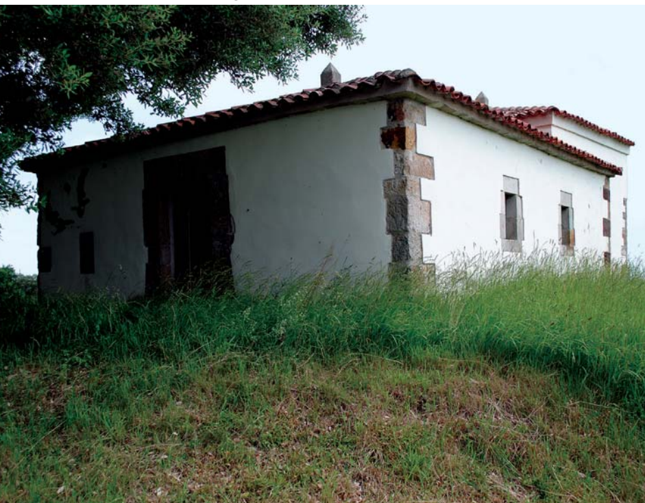
Vista general de la nave
