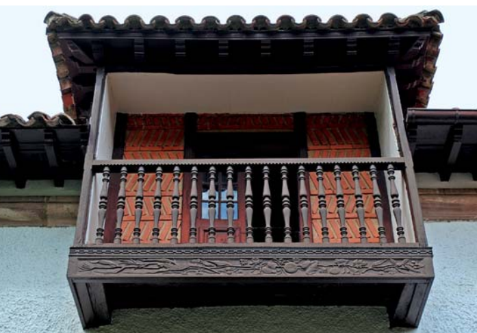
Balcón. Fachada este del edificio anexo
