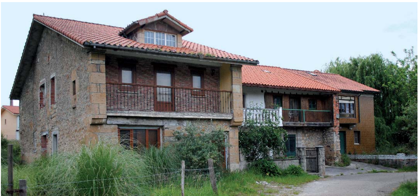
Casas adosadas en el barrio de Santa Ana
