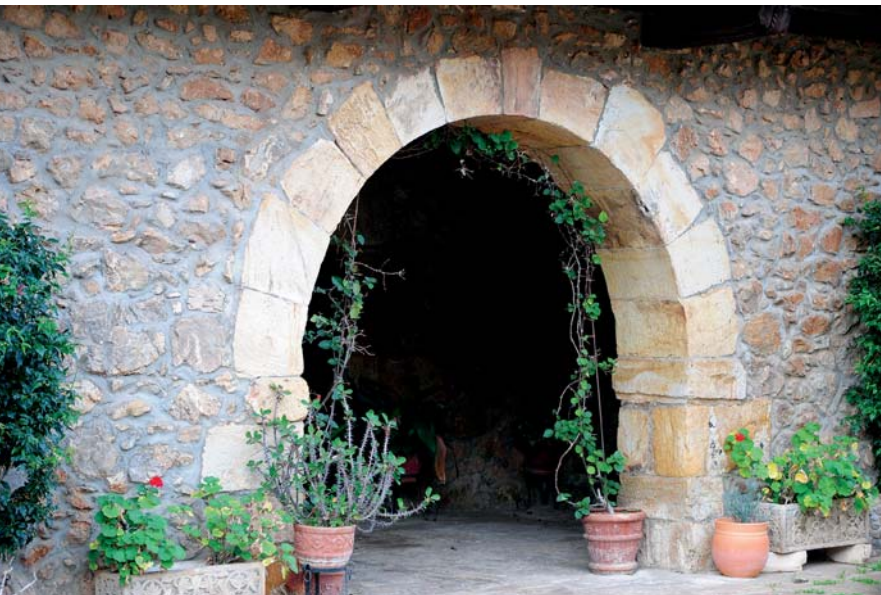
Detalle del arco de medio punto
