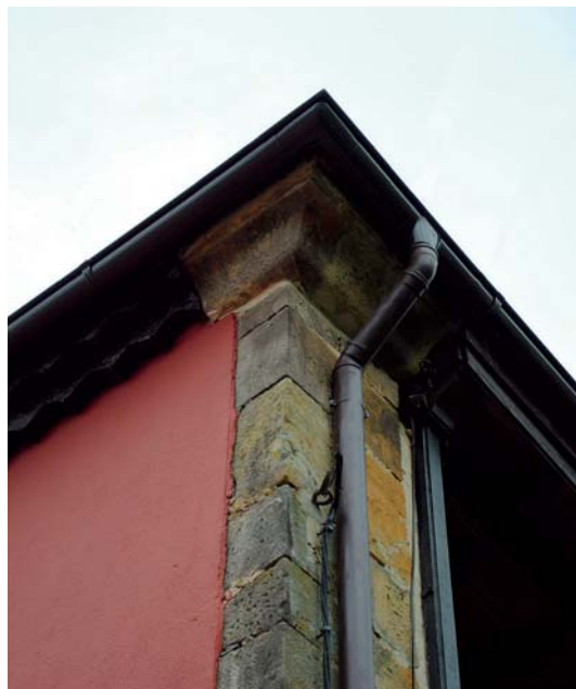
Detalle del remate del cortafuegos
