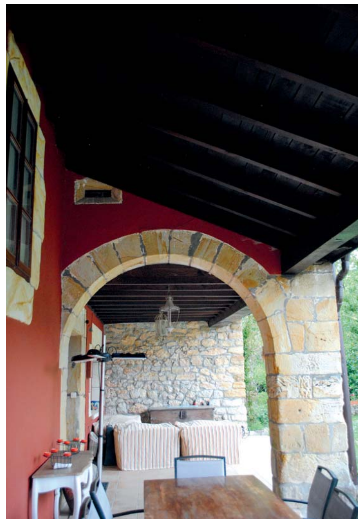
Detalle del pórtico con el vano en forma de buzón
