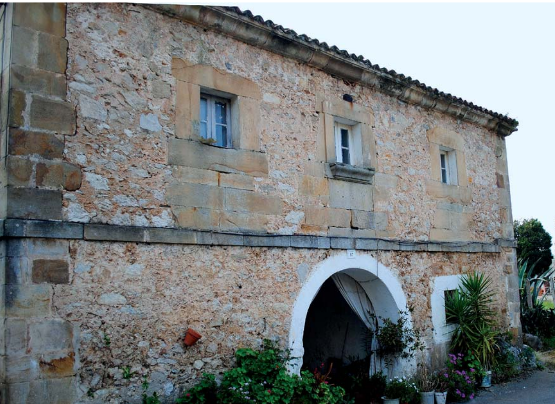
Barrio la Aldea. Casa del XVII. Antiguo cuartel de la Guardia Civil. Fachada noreste con gran arco de entrada y cornisa en pecho de paloma
