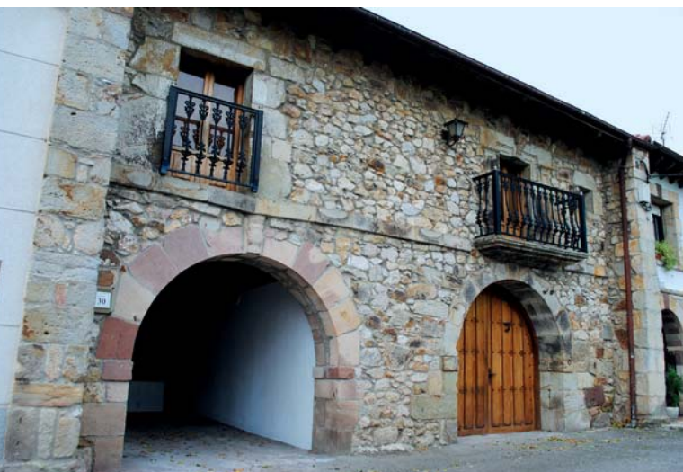
Fachada en mampostería, con partes nobles en sillería (Villanueva)
