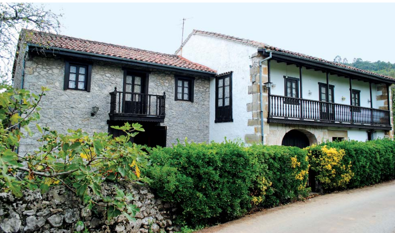
Barrio la Aldea. Casa del XVIII con amplia solana y edificio adosado
