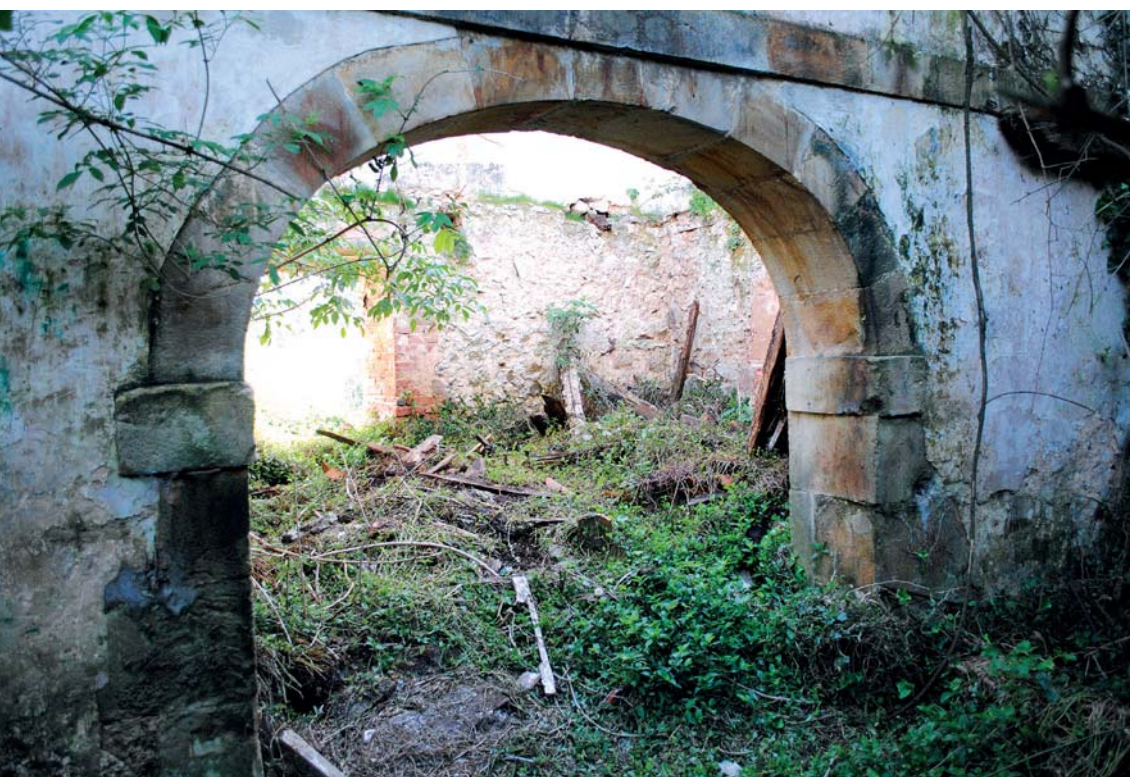
Portada de sillería realizada en arco de medio punto rebajado
