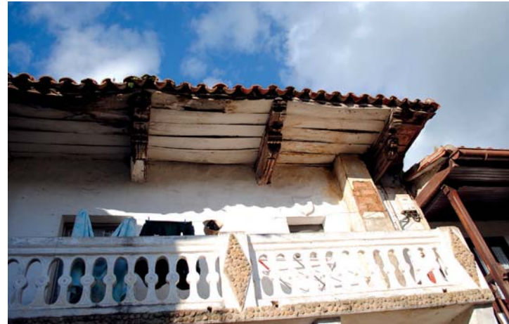
Detalle de ménsulas antiguas y placa de escudo sin labrar
