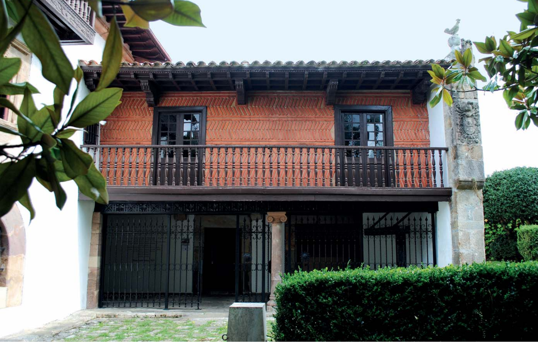
Fachada sur, con la solana y el escudo nobiliario
