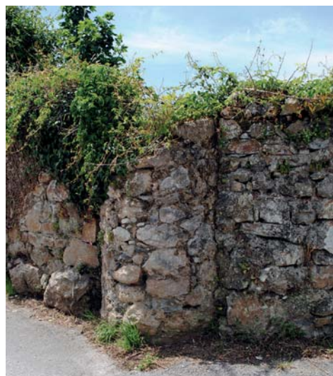
Estado actual del humilladero
