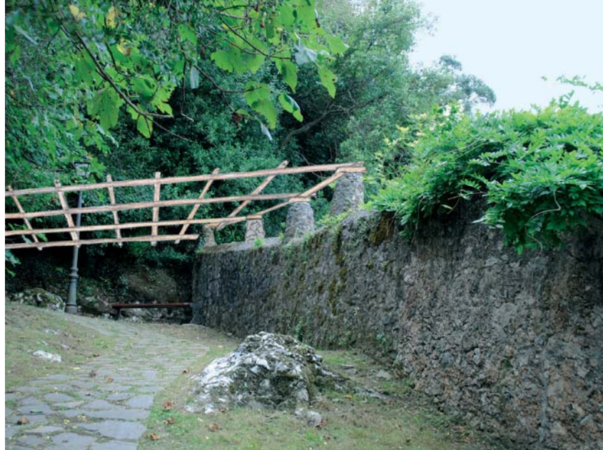
Reconstrucción del entramado
