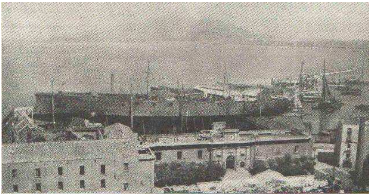
Il Dante Alighieri sullo scalo nel cantiere di Castellammare di Stabia
