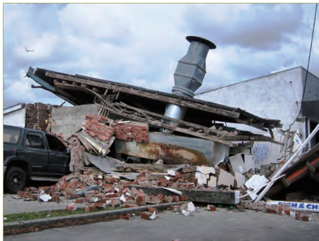
2011年基督城地震倒毀的建築物 (photo by Martin Luff，拍攝地點位於基督城的New Brighton，資料來源： http://www.flickr.com/photos/23934380@N06/ )。
