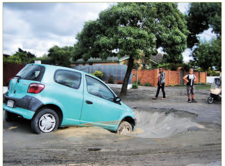
2011年基督城地震發生後，基督城北方發生土壤液化造成汽車陷入 (photo by Martin Luff，拍攝地點位於基督城的新布萊頓)。
