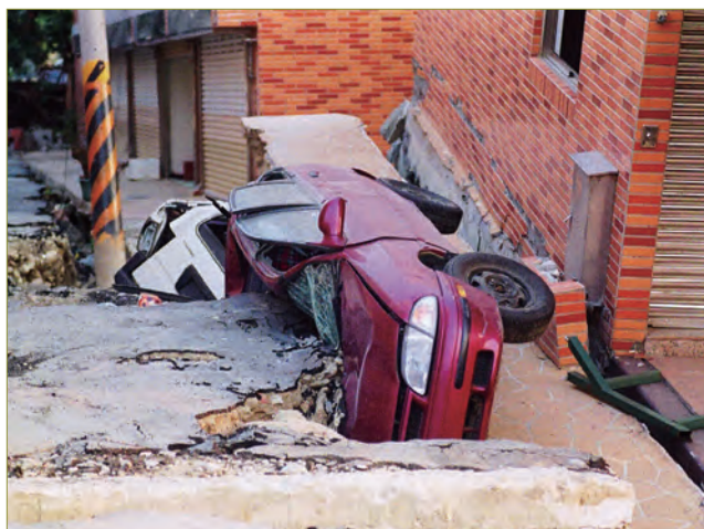
921集集地震時，在臺中石岡埤豐橋附近所拍攝之照片。照片中可觀察到兩種現象，一是右方房屋因為土壤液化的關係而傾毀；二是地震於汽車停放處產生一寬約2公尺的裂隙，待汽車陷入後，大地再度癒合 (朱倣祖攝)。
