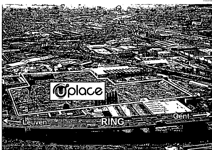
Luchtfoto projectgronden na aankoop / sanering
