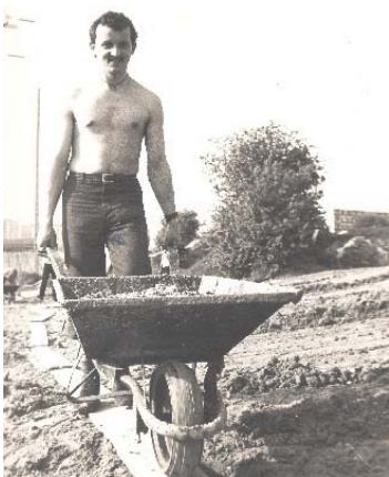
Praca przy budowie ścieżki zdrowia, ..., 1979 r.
