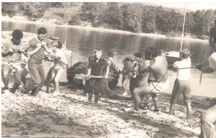
Budowa ośrodka żeglarskiego w Żywcu lata 70.
