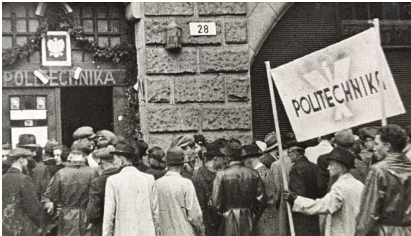
Budynek Domu Technika przy ul. Straszewskiego 28, pozyskany przez Komitet Organizacyjny PK na swoją siedzibę
