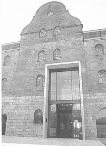
Kulturspeicher Würzburg – Ein Lagerhaus des frühen 20. Jahrhunderts wurde zu einem zeitgemäßen Museumsbau umgenutzt. Foto: Museum im Kulturspeicher Würzburg
