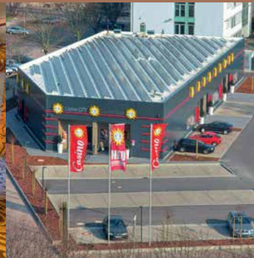
Das Unternehmen installiert Photovoltaik-Anlagen auf eigenen Spielothek-Immobilien
