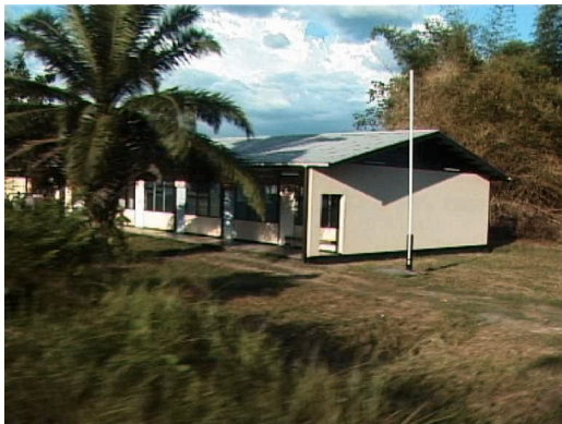
Het nieuwe, brandbestendige Bureau voor Burgerregistratie (foto: KA).
