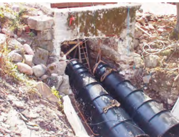
Rakennustyöt tapahtuivat vuonna 2006
