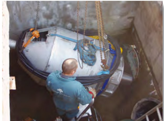
Turpiinasennukset suoritettiin v. 2006 loppupuolella
