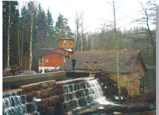
Yläkanavan muurattu koskenpuolinen patoseinä toimii ylisyyökykynnäksenä
