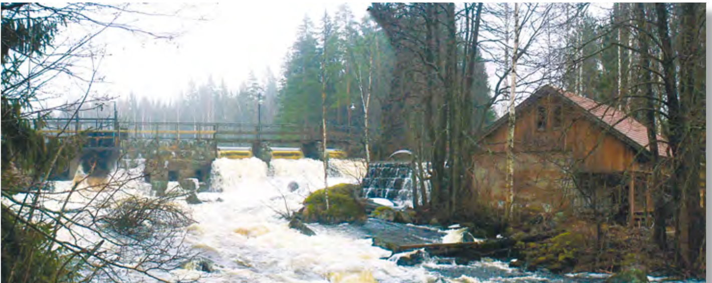
Pato alavirran puolelta katsottuna. Kiinteä padonosa on vain lyhyt. Pääosaa leveydestä hallitsevat ohjjuoksu- ja tulvaluukut.
