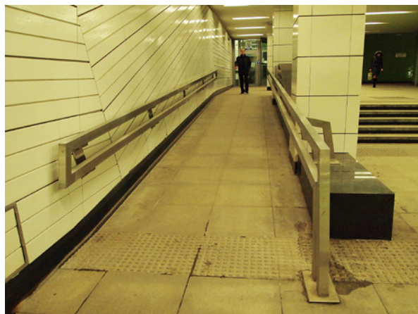
Фото 21. Двойные непрерывные поручни прямоугольного сечения толщиной более 30 мм на ст. Новокосино.
