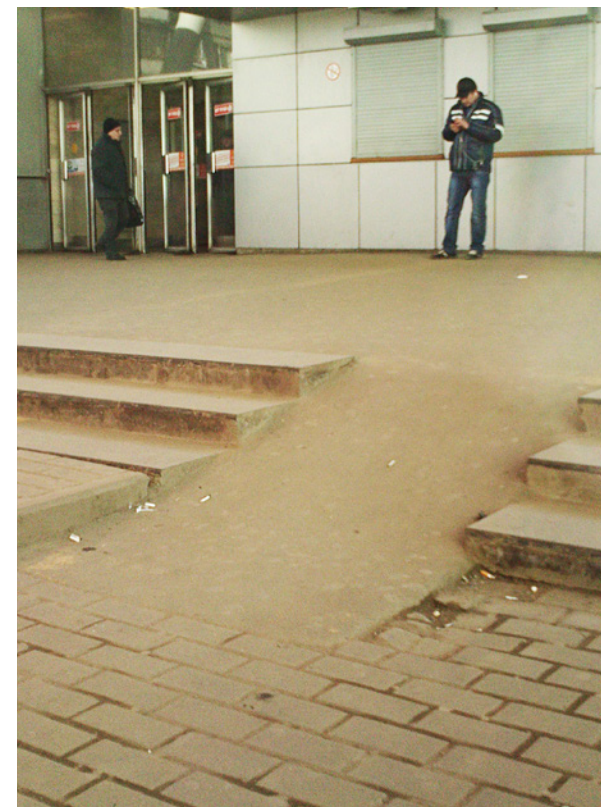
Фото 19. Не оборудованный поручнями наружный пандус с высотой подъема более 150 мм у входа на ст. Планерная.
