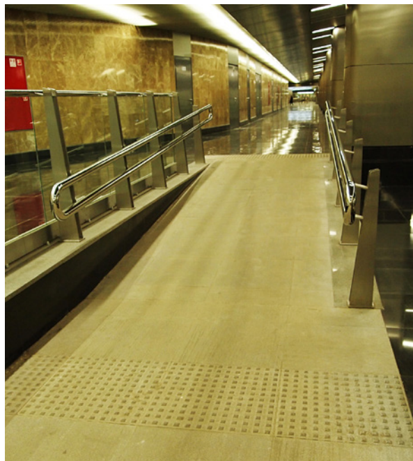
Фото 21. Двойные непрерывные поручни прямоугольного сечения толщиной более 30 мм на ст. Новокосино.
