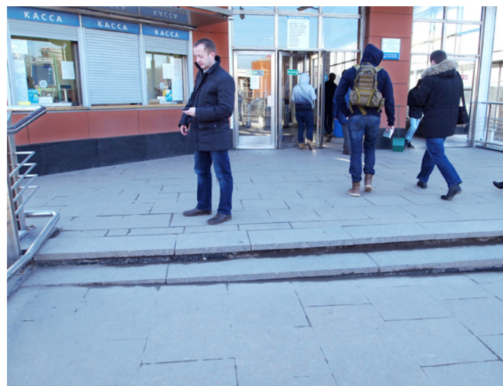
Фото 3. Лестница из 1-2 ступеней (одиночная ступень) у входа на ст. Кунцевская.
