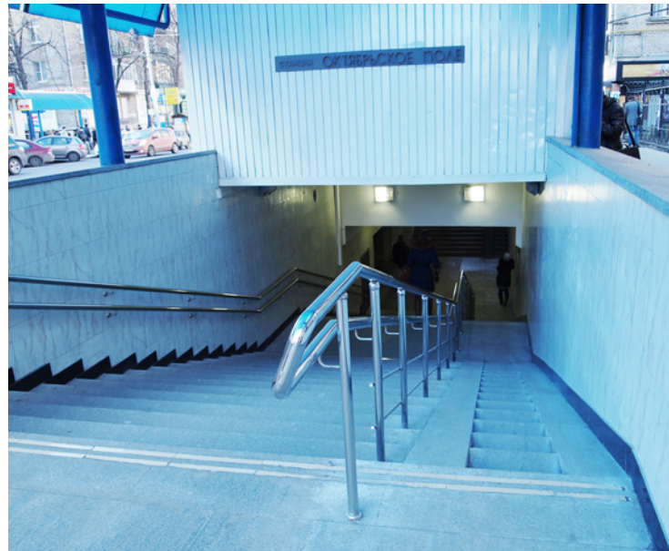
Фото 10 и 10а. Лестницы с рельсами на ст. Бибирево и ст. Октябрьское поле.
