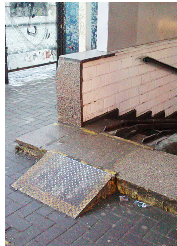
Фото 35. Пандус с уклоном 36% между одиночной ступенькой и тротуаром на ст. Сходненская.
