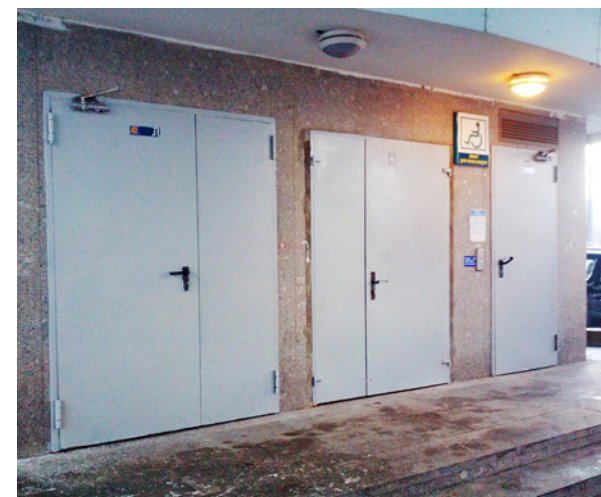
Фото 32. Ведущие в лифт двери на ст. Бунинская аллея.
