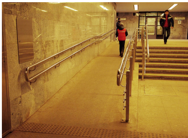
Фото 17. Пандус на ст. Пятницкое шоссе с расстоянием между поручнями 1300 мм.
