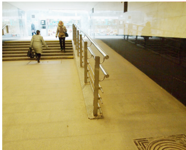
Фото 29. Пандус на ст. Строгино с уклоном 9%, оборудованный поручнем только с одной стороны.
