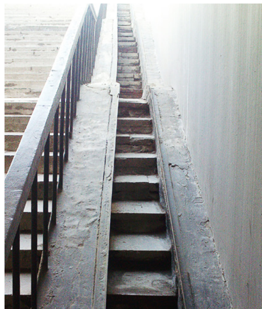
Фото 40. Слева — неровные рельсы на ст. Крылатское, справа — бетонные рельсы на ст. Октябрьское поле, которые становятся скользкими во время дождя или таяния снега.
