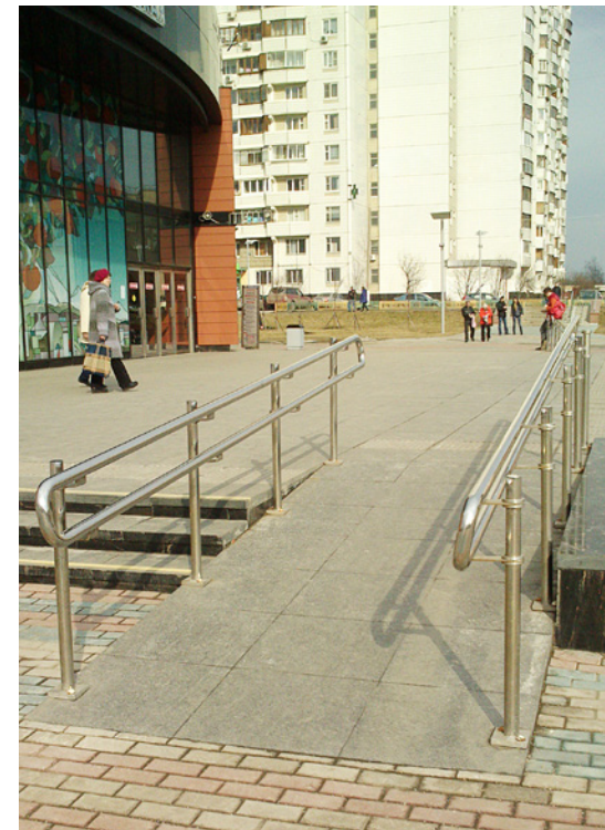
Фото 30. Пандус у входа на ст. Алма-Атинская с уклоном 10% и расстоянием между поручнями 1500 мм.
