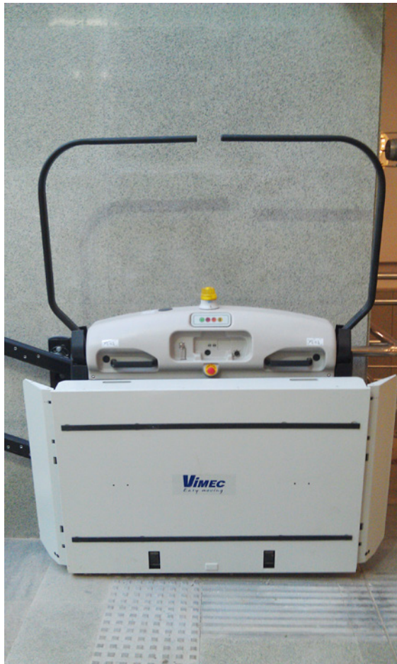
Фото 2. Подъемная платформа с наклонным перемещением на ст. Лесопарковая.
