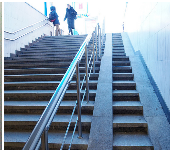
Фото 40. Слева — неровные рельсы на ст. Крылатское, справа — бетонные рельсы на ст. Октябрьское поле, которые становятся скользкими во время дождя или таяния снега.
