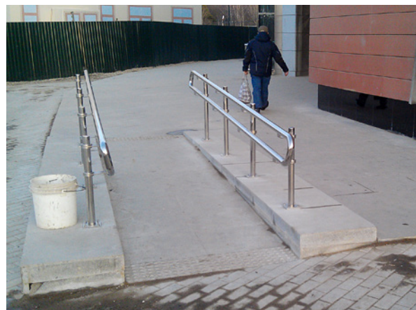
Фото 18. Оборудованный поручнями наружный пандус с высотой подъема менее 150 мм рядом со ст. Битцевский парк.
