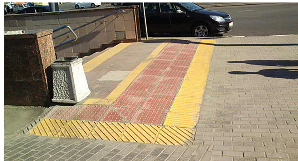
Фото 36. Наклонная поверхность для подъема на площадку перед сходом в подземный вестибюль ст. Преображенская площадь.
