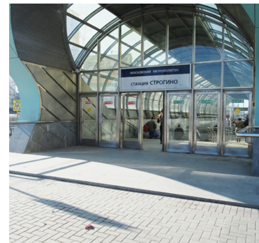
Фото 26. Ступенька высотой 8 см перед входом на ст. Строгино.
