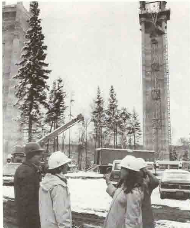
Olympic representatives tour ski jump complex during construction Les délégués Olympiques visitent la construction du complexe de saut à ski
