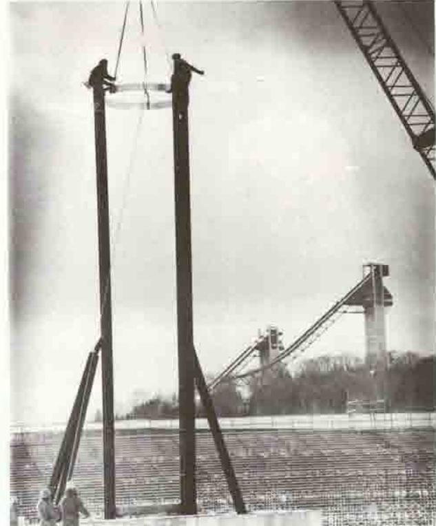
Construction of Olympic Flame tower with ski jumps in background Construction de la tour destinée à porter la Flamme Olympique avec les tremplins en arrière-plan
