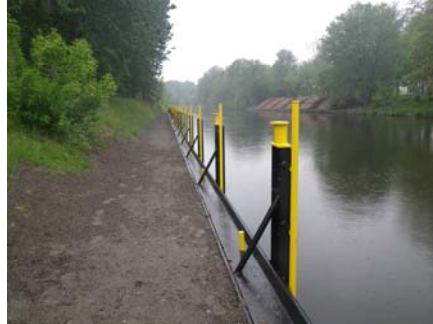
moderne Sportbootwartestelle am Beispiel Schleuse Bredereiche
