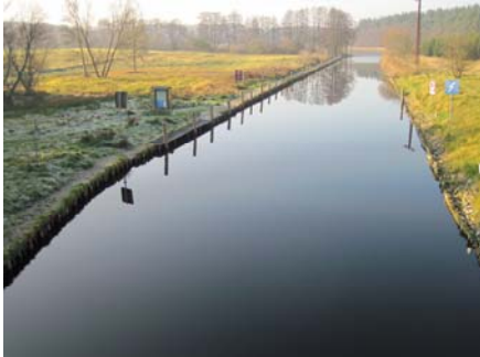
Blick auf die Wartestelle im Oberwasser vor Baubeginn
