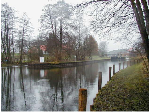
Blick auf die Wartestelle im Unterwasser der Schleuse Diemitz vor Baubeginn
