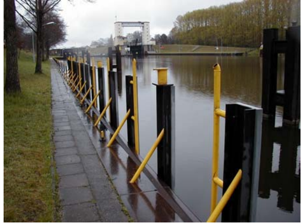
Beispiel für eine moderne Sportbootwartestelle an der Schleuse Lehnitz
