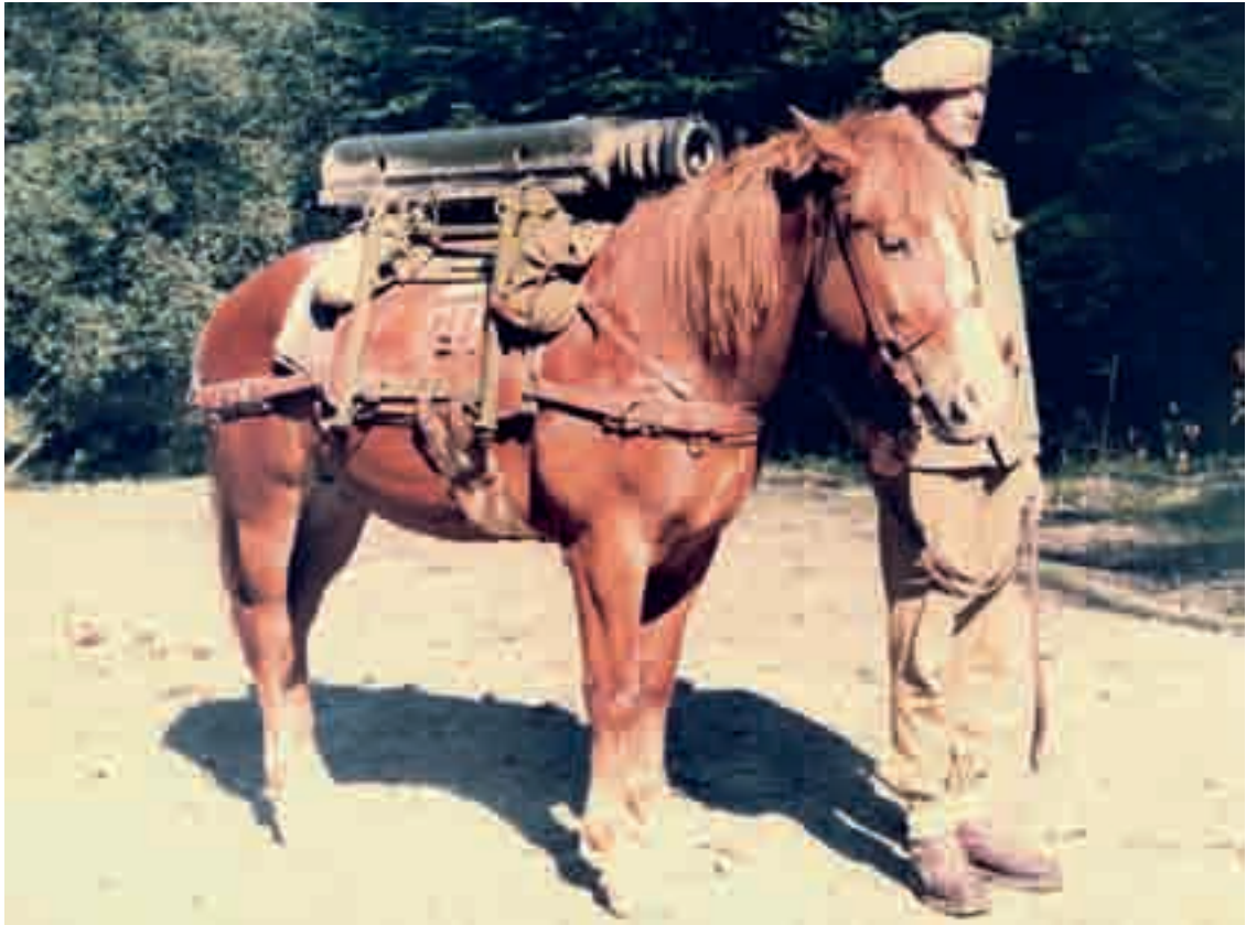
Țeava tunului de munte calibrul 76 mm transportată pe samar
