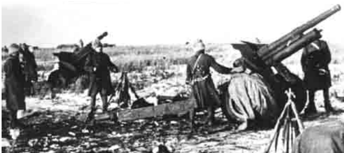
Baterie de artilerie pe frontul de est - 1941
