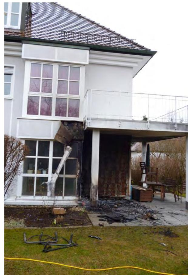
Die Entzündung eines Gartenstuhls führte (möglicherweise über den ungeschützten Sockelabschluss) zum raschen Abbrand des WDVS. Das Gebäude konnte gerettet werden, da der Brand frühzeitig erkannt wurde und die Hilfsfrist deutlich unter 10 min lag.
