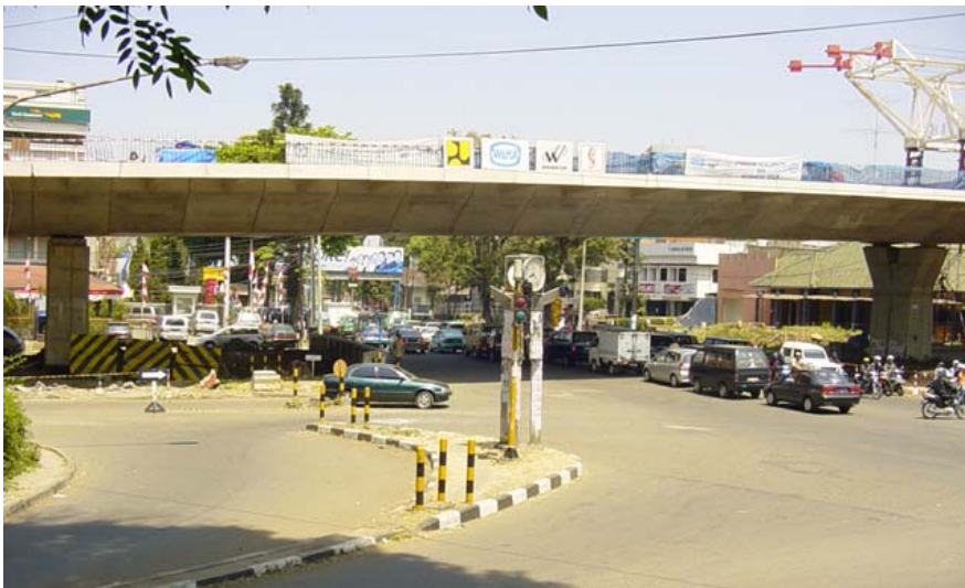
▼ Viaduct crossing Jl. Dago
