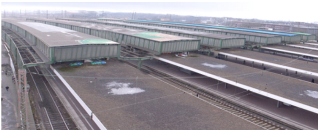
Abbildung 85: Bestand Hallendach Duisburg; Quelle: DB Station&Service AG
