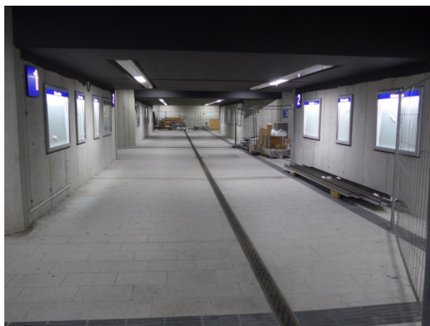
Abbildung 103: Neue Unterführung Januar 2016 während Montagearbeiten an Aufzügen und vor Gestaltung der Wände, Quelle: DB Station&Service AG
