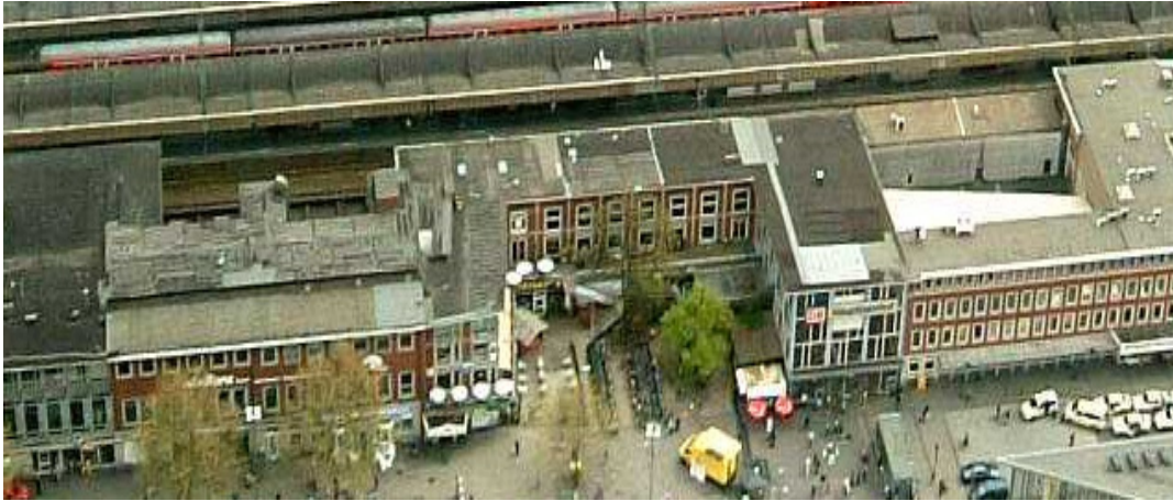
Abbildung 89: Foto Bestand altes Empfangsgebäude; Quelle: DB Station&Service AG
