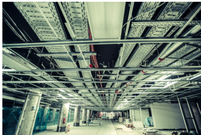
Abbildung 96: Bild aus der Bauphase; Quelle: I.SBH
