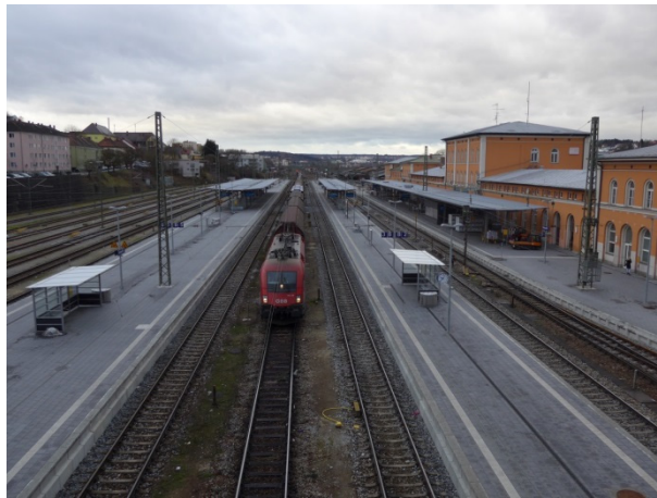
Abbildung 101: Übersichtsbild Januar 2016, Quelle: DB Station&Service AG
