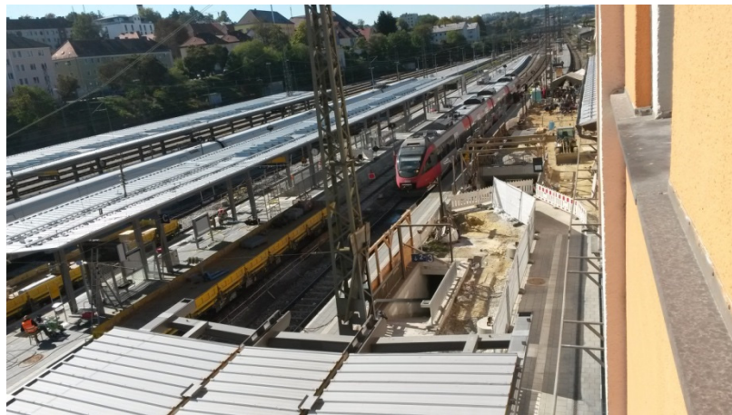
Abbildung 102: Überblick über Bauarbeiten im Oktober 2015 aus dem Empfangsgebäude, Quelle: DB Station&Service AG
