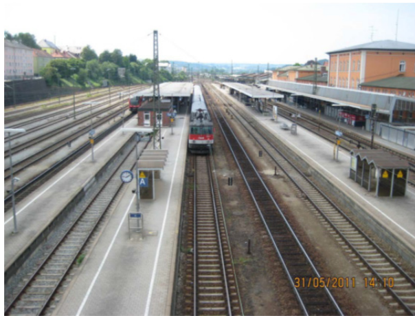
Abbildung 100: Übersichtsbild vor Beginn des Umbaus, Blick nach Westen, Quelle: DB Station&Service AG
