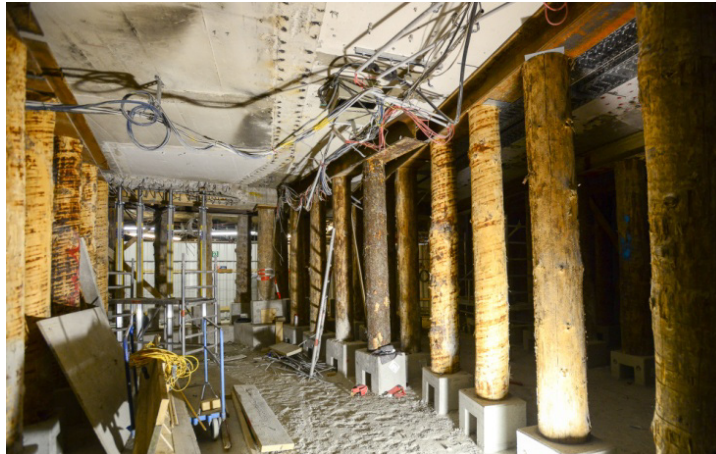
Abbildung 95: Bild aus der Bauphase; Quelle: I.SBH
