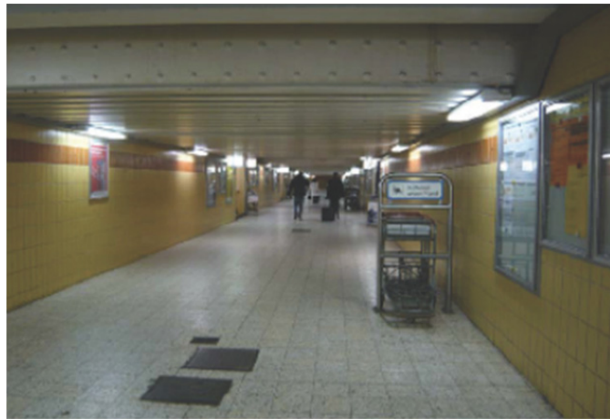
Abbildung 104: Bestehende Bahnsteigunterführung, Quelle: DB Station&Service AG
