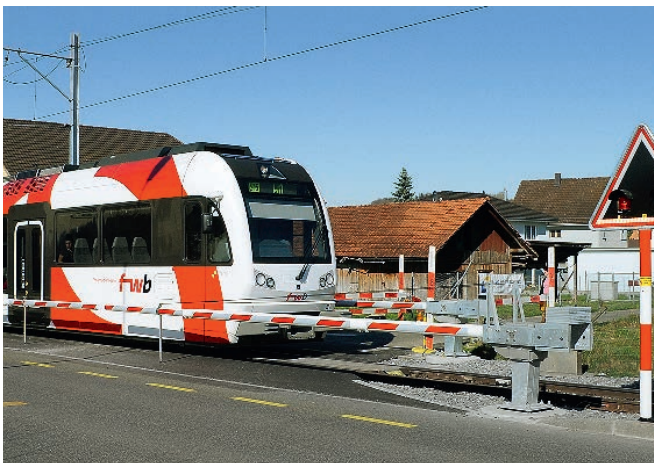
Bahnübergang saniert: Matzingen, Hardstrasse
