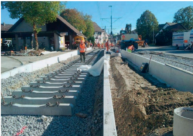
Einbau der Gleise in Matzingen, 9. Oktober 2014
