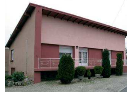
Maison à 1 pan -Rue de la Fontaine
