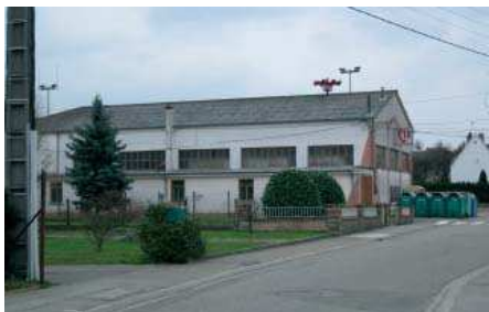
Bâtiment des services techniques
