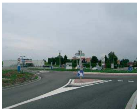
Entrée Est (RD 83a venant d'Enchenberg)
