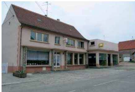
Maison de commerçant - ancien boucher
