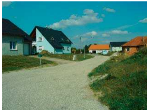
Lotissement - Rue des Pommiers
