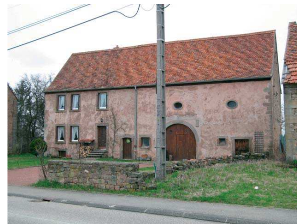
Ferme à 2 niveaux sans avant-corps - Rue des Alliés
