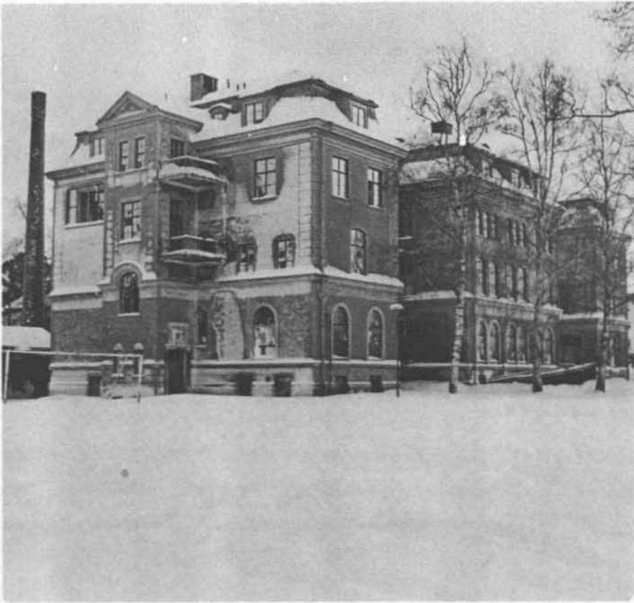
Sollefteå gamla lasarett representerar en blandning av byggnadsstilar.
