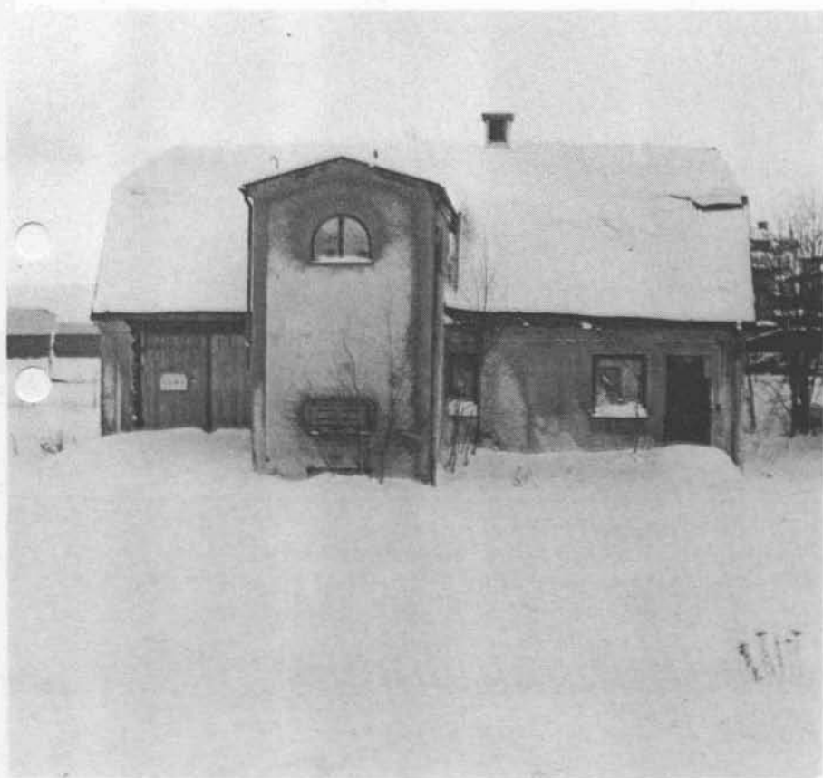
Tvätteribyggnaden sedd från framsidan.
