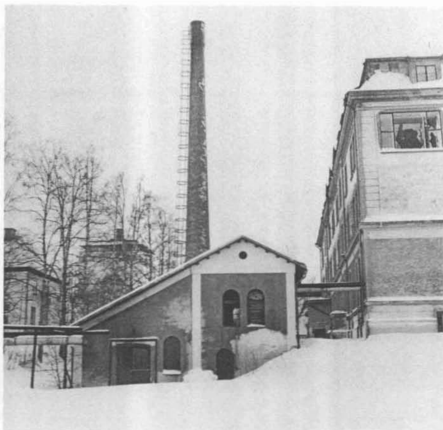
Pannhusets höga skorsten berättar om byggnadens funktion.
