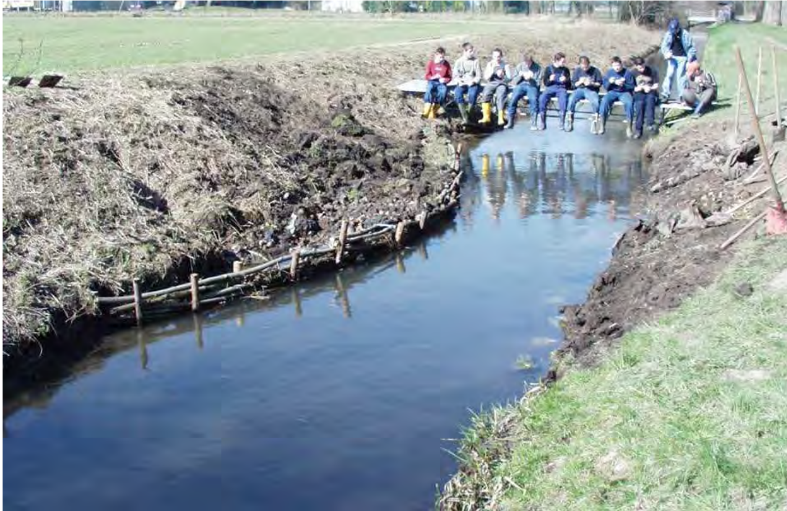
Umweltprojekt Realschule Süd/ Umweltamt Neuss /Erftverband: Renaturierung eines Teilstückes des Gillbachs
