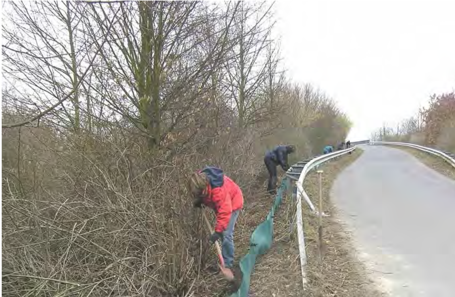
Installation eines Amphibienschutzzaunes an der Bauerbahn
