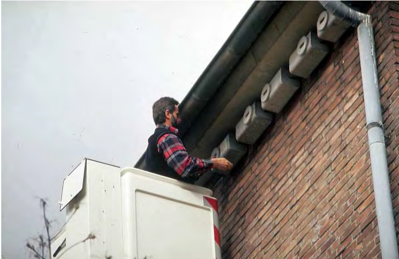
Montage von Mauersegler-Nistkästen an der Weberstraße
