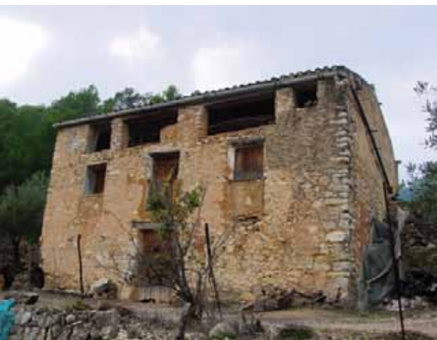
Mas de l'Aves (Paüls) amb accés pel mur de càrrega.
