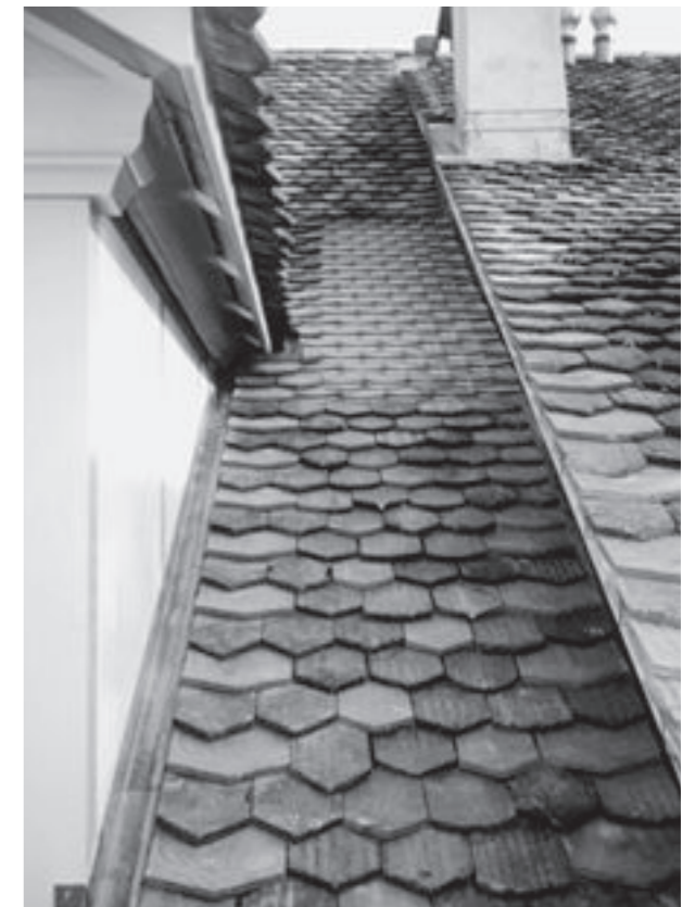
Lukarnendetail und Glasziegelband der neuen Belichtungselemente.
