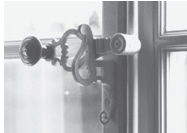
1. Stock, Aareseite, Salon. Im Haus vorgefundene und wiederverwendete Fensterbeschläge.
