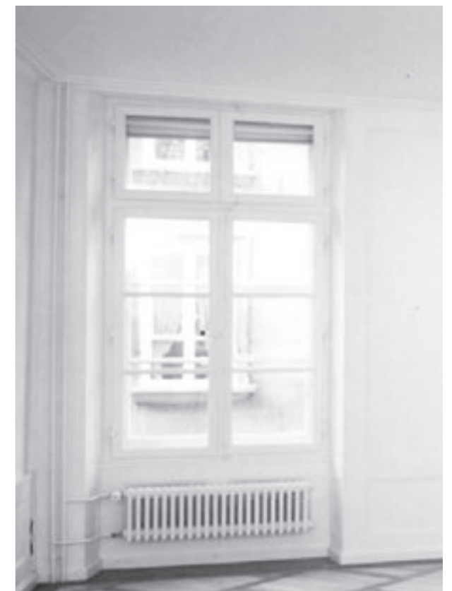
2. Stock, Gassenseite. Gleiches Fenster von innen.
