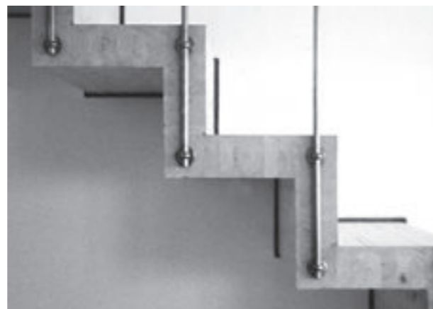
Dachwohnung, Gassenseite. Detailaufnahme der Treppe und -geländer.
