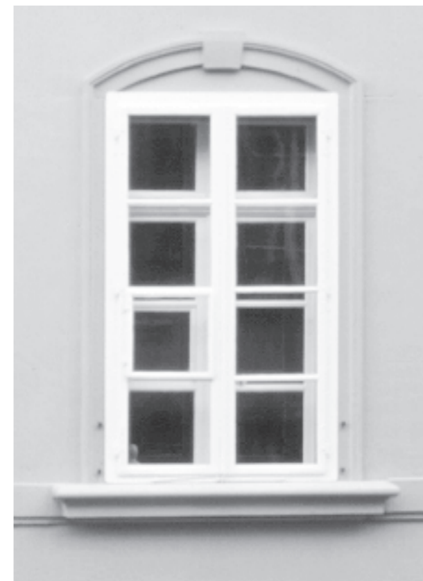
Fassade Junkerngasse, 2. Stock. Fenster und Vorfenster von 1730/40.
