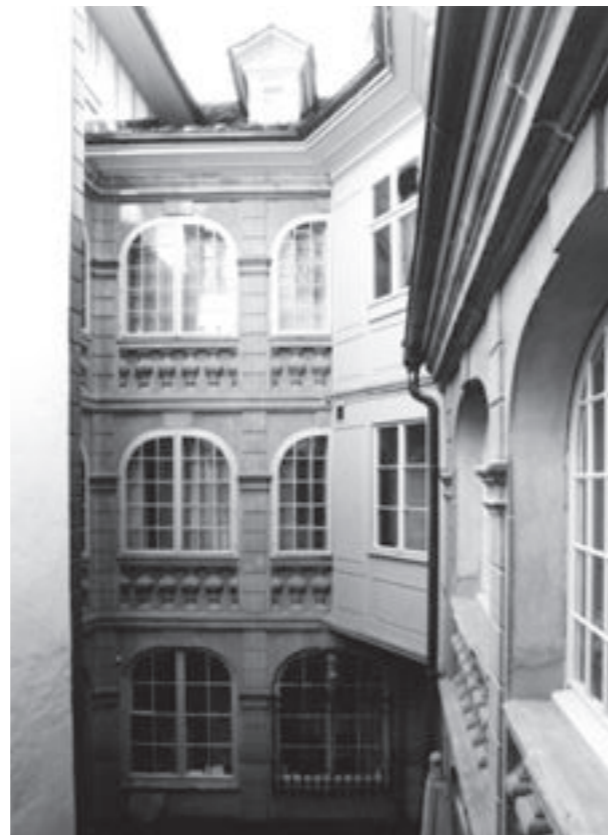
Innenhof vor dem Entfernen des störenden Verbindungsganges.
