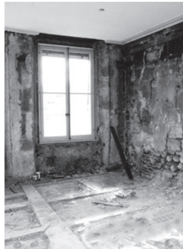
1. Stock, Aareseite, Salon. Der Parkettboden und die Wandtäfer sind ausgebaut. Im untern Bereich der Wand (rechts) Reste einer Bollensteinmauer, vermutlich 13. Jahrhundert; Bodenkonstruktion: doppelte Balkenlage 1730/40 auf ältere Bohlendecke aufgelegt; Gipsdecke gegen Ende 18. Jahrhundert erneuert; Fenster beim spätbarocken Umbau verschmälert und erhöht.
