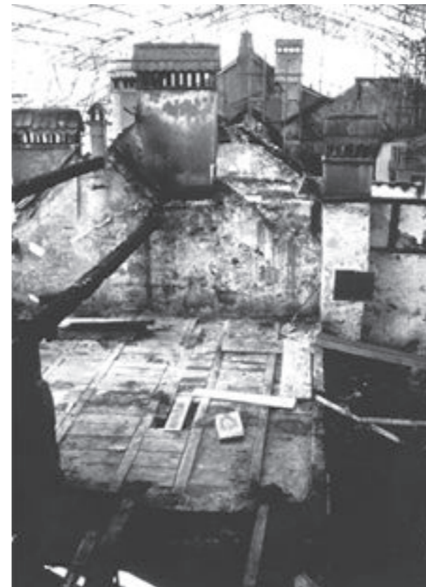
April 1997. Die Dachstöcke an der Aareseite sind abgebrochen und das Notdach ist aufgerichtet.
