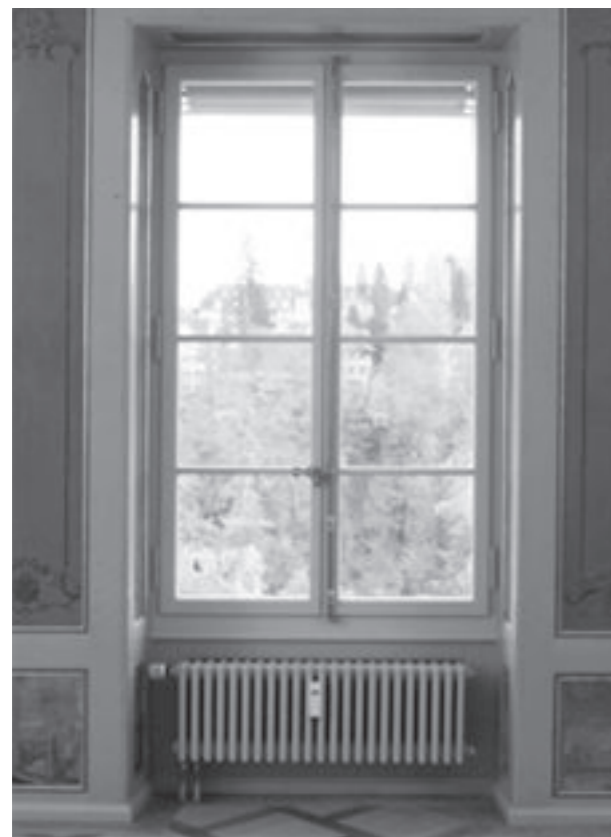
2. Stock, Aareseite, Festsaal. Neues Fenster mit den wiederverwendeten, alten Beschlägen.
