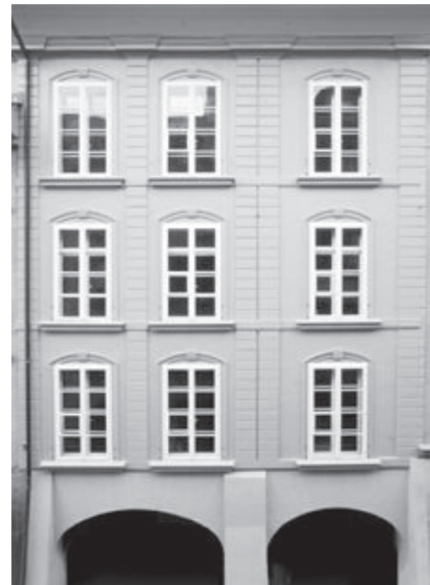
Fassade Junkerngasse. Die Fassadengliederung 1730/40 (Stichbogenfenster und gefugte Lisenen) lässt die ursprüngliche Zweiteilung des Hauses erkennen.
