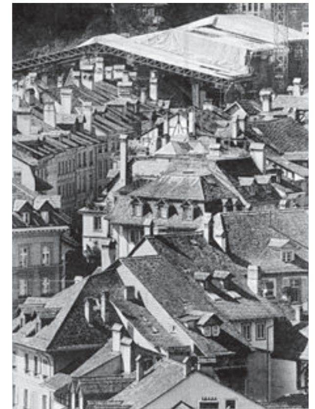
April 1997. Das Notdach überspannt die Baustelle.
