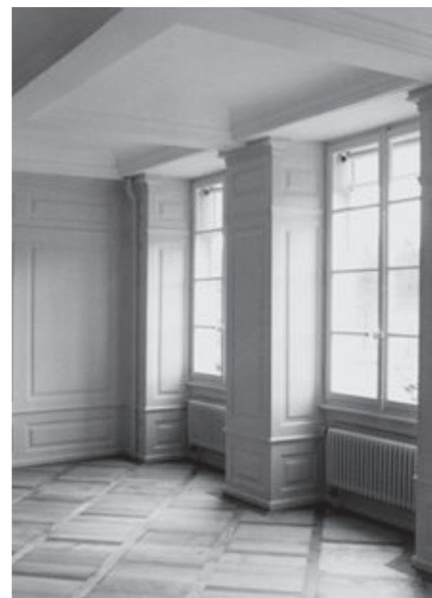
Erdgeschoss Aareseite, Salon. Nach Wiederaufbau. Kassettendecke mit Spiegelgewölben, originale Wandtäfer und Parkettboden wieder eingebaut, Fenster und Heizung neu.
