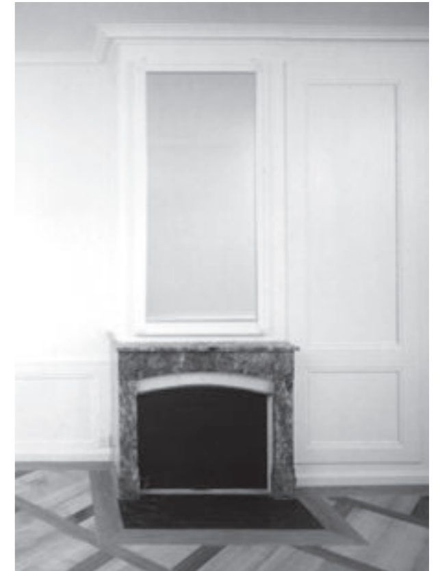
2. Stock, Gassenseite, Hofzimmer. Intérieur aus der Zeit des spätbarocken Umbaus. Cheminée aus rosa-weiss geädertem Oberhasli Marmor, um 1810.
