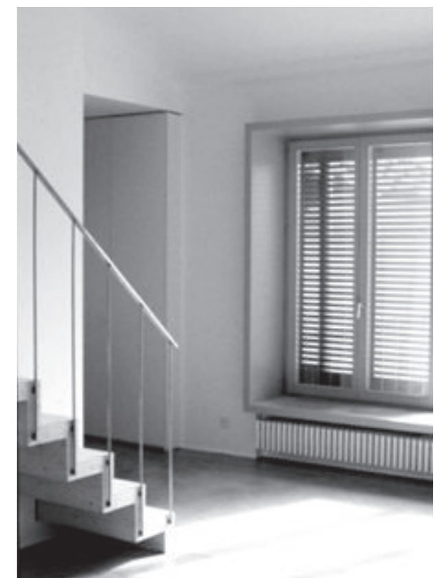
Dachwohnung Gassenseite, Wohnraum. Nach Wiederaufbau. Neues, grosses Fensterelement mit Schiebeläden gegen Hof, tonfarbener Holzzementboden, Treppe aus Brettschichtholz.
