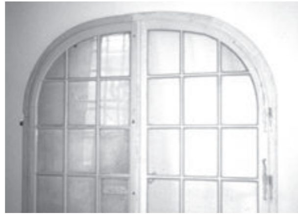
Erhaltene Hälfte des Fensters aus der Zeit 1730/40 (links) und neu ergänzte Hälfte (rechts).
