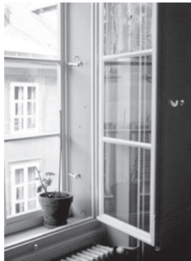
3. Stock, Gassenseite. Neu gefertigte, einfachverglaste Fenster und Vorfenster.
