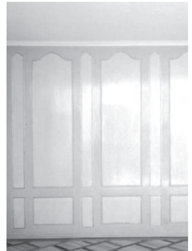
1. Stock, Aareseite, Salon. Zweizoniges Wandtäfer, schmale und breite Felder im Wechsel, Füllungen mit aufgesetzten Traversen, oben karniesbögig abgeschlossen, 1730/40. Die ursprüngliche Farbgebung wurde wieder hergestellt. (Vergleiche Seite 7).
