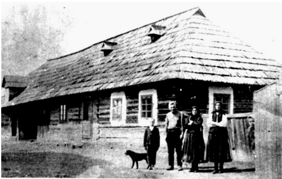
„Gerezdbe épített, dránicával fedett ház”
