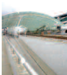
Futura Estação do Aeroporto
