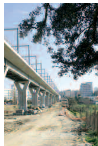
Viaduto Maia Norte
