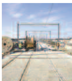
Viaduto Maia Norte
