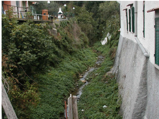
Dalla Sez. 3 (imbocco tombinatura) verso monte
