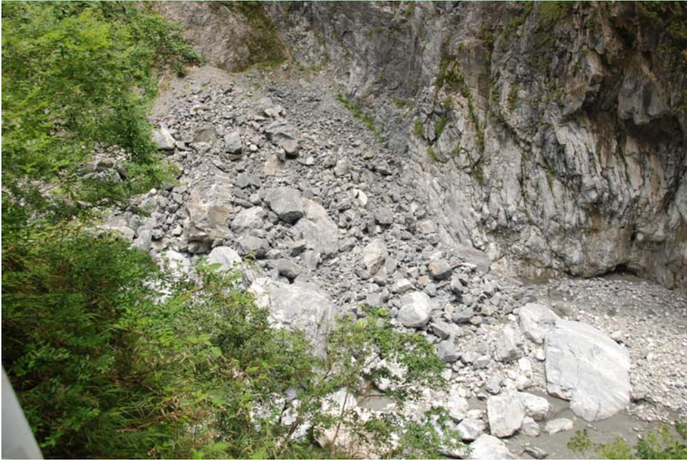
圖 4-34 九曲洞-綠水河段 F 點第二崩塌地。
