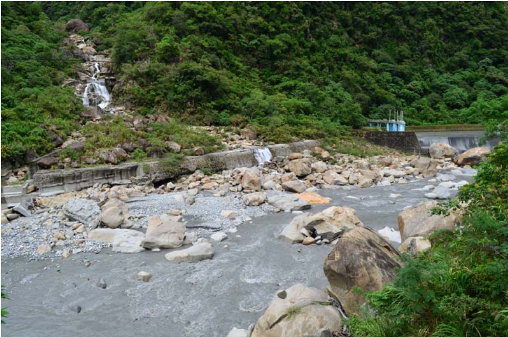
圖 4-20 白沙橋-燕子口段 C 點，溪畔壩近下游側。
