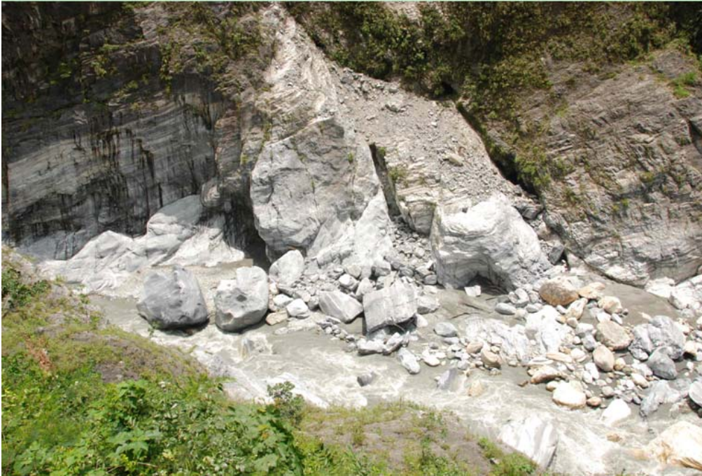
圖 4-29 九曲洞河段 A 點崩塌處與巨礫。
