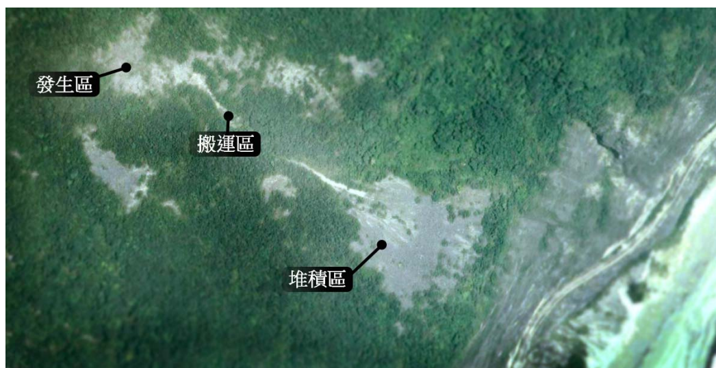
圖 4-83 航照下的臨海崩石坡
