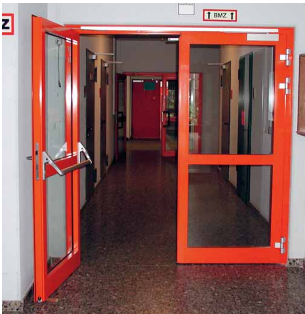
Abb. 1: Aufkeilen einer selbstschließenden Brand- und Rauchschutztür
