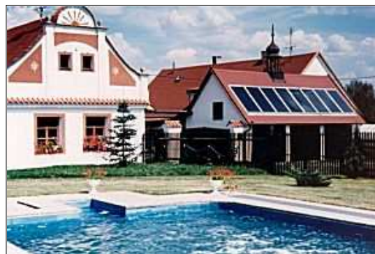
Obr. 14: Vyhřívání vody v bazénu pomocí slunečních kolektorů na střeše
