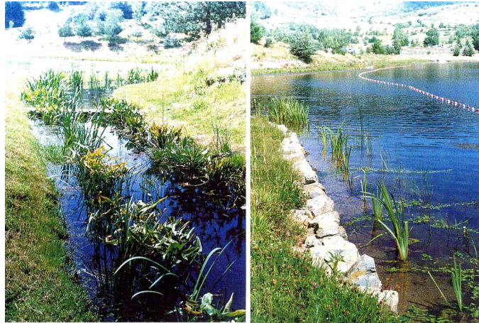
Plantation du chenal et des berges avec protection contre le batillage
