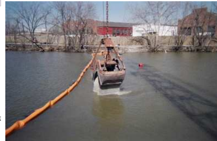
Recouvrement des sédiments à l'aide de matériaux "naturels" (en orange: barrage anti-turbidité)
