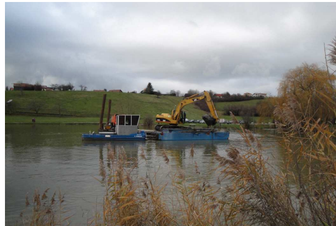
Dragage mécanique du lac de Machilly (drague pelleuse)
