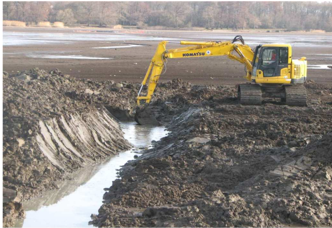
Réalisation de saignées de drainage sur l'étang de Forges
