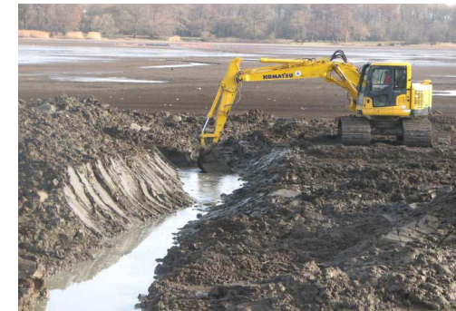
Réalisation d'une saignée de drainage - étang des Forges
