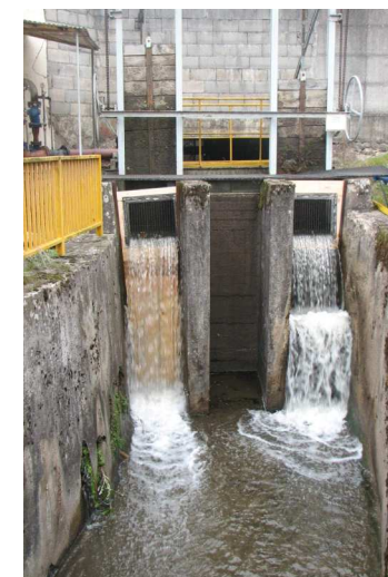
Ouverture des vannes de vidange - étang des Forges
