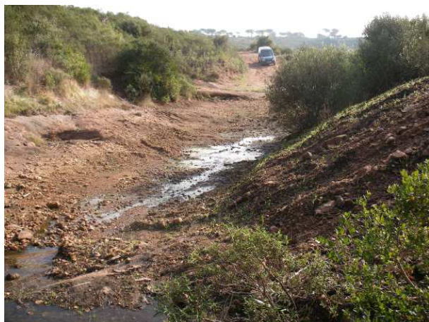
Après travaux de curage, septembre 2009
