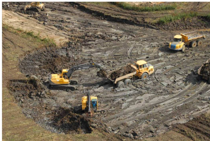
Chantier d'extraction des sédiments de l'étang des Forges
