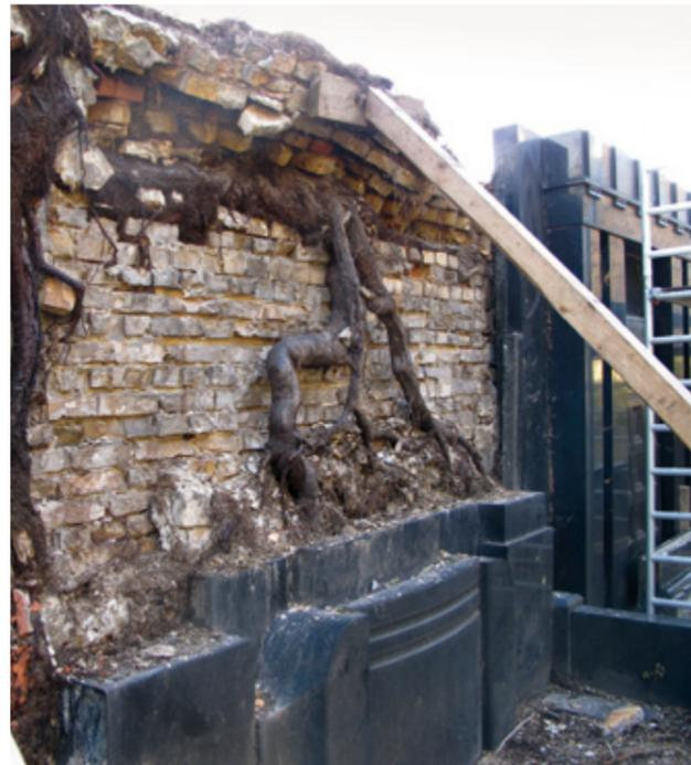
Abb. 48: Schädigungen durch spontane Vegetation: durch in der Friedhofsmauer wurzelnde Gehölze abgelöstes und eingestürztes Erbbegräbnis.
