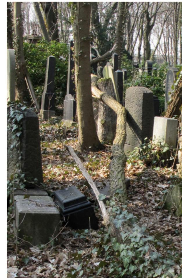
Abb. 49 - 50: Schädigungen durch spontane Vegetation; links: infolge eines Baumsturzes mitgerissene Individualgrabmale; rechts: durch Wachstum der Wurzeln des Baumes wird das Grabmal beiseitegeschoben
