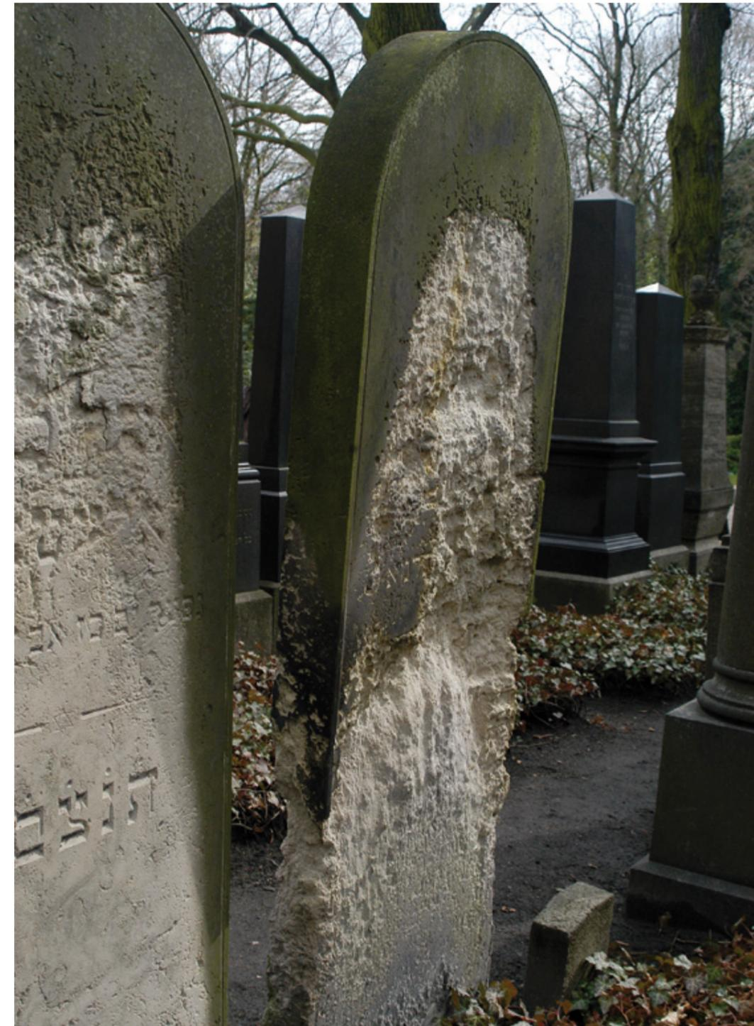
Abb. 54: Verlust der Inschriften; durch Rahmenverwitterung fast vollständig zerstörte Tafel aus Sandstein
