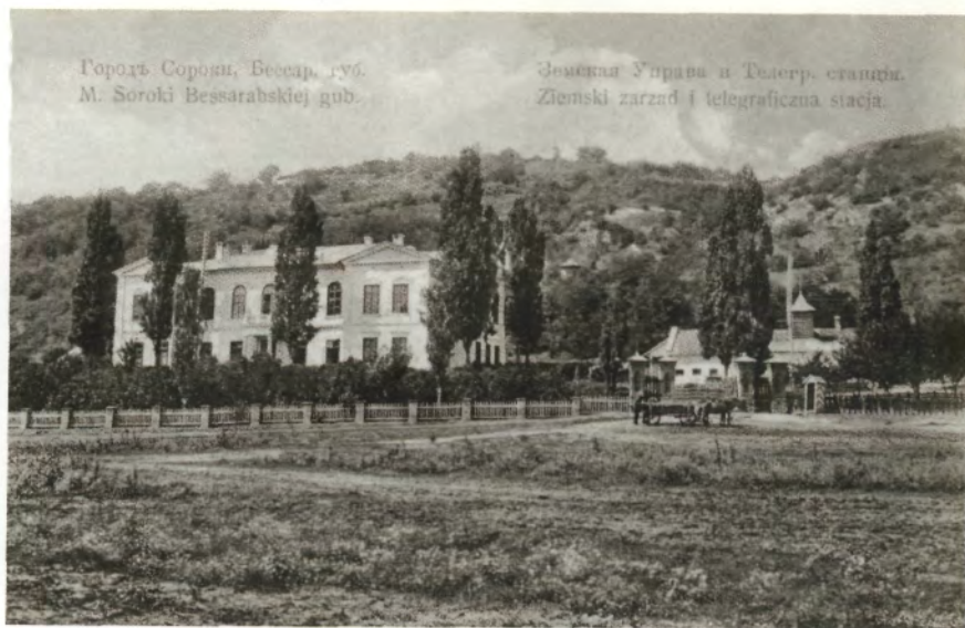
Clădirea Zemstvei și stația de telegraf, sf. sec. XIX
