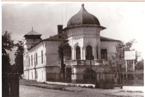
Casa Ion Hagiescu Miriște- vedere din față (Arhiva familiei Pătru)
