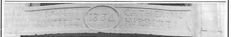
L'inteau du 31 rue du Lavoir datant de 1834.
