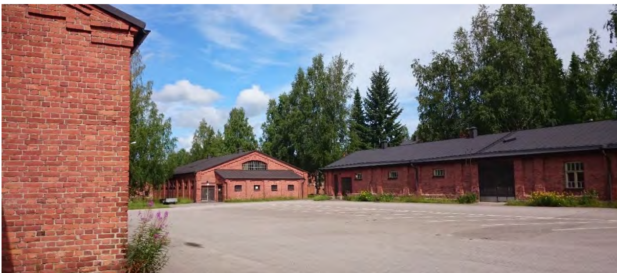
Yllä rakennukset 39 ja V40. Alla rakennusten 41, 39 ja 44 rajaama nykyistä piha-alueita..
