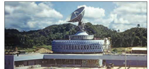
Наземный комплекс на Кубе
