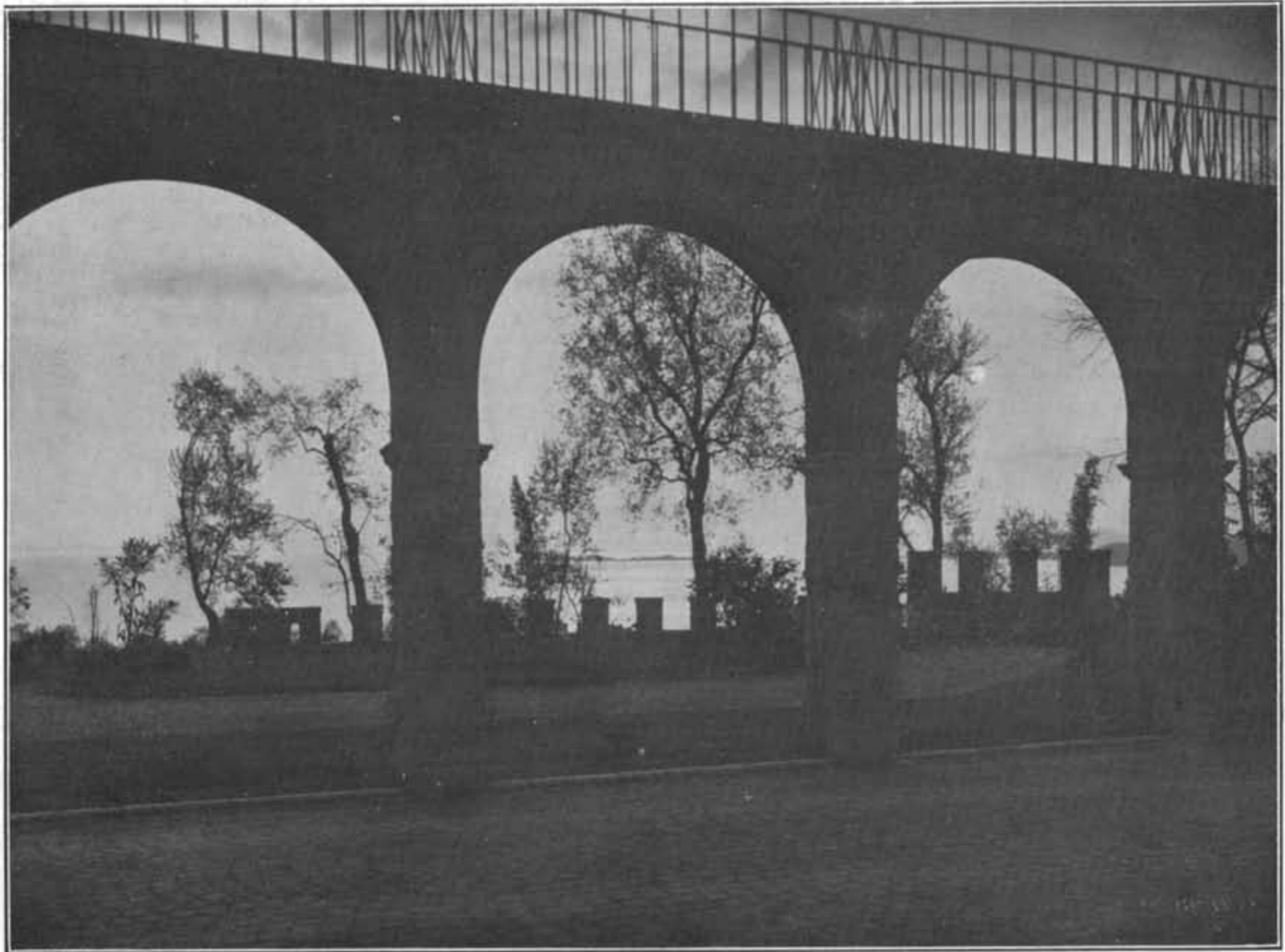
DETTAGLI DEI CAVALCAVIA CIRCOSTANTI ALLA PIAZZETTA DELLA VITTORIA.
