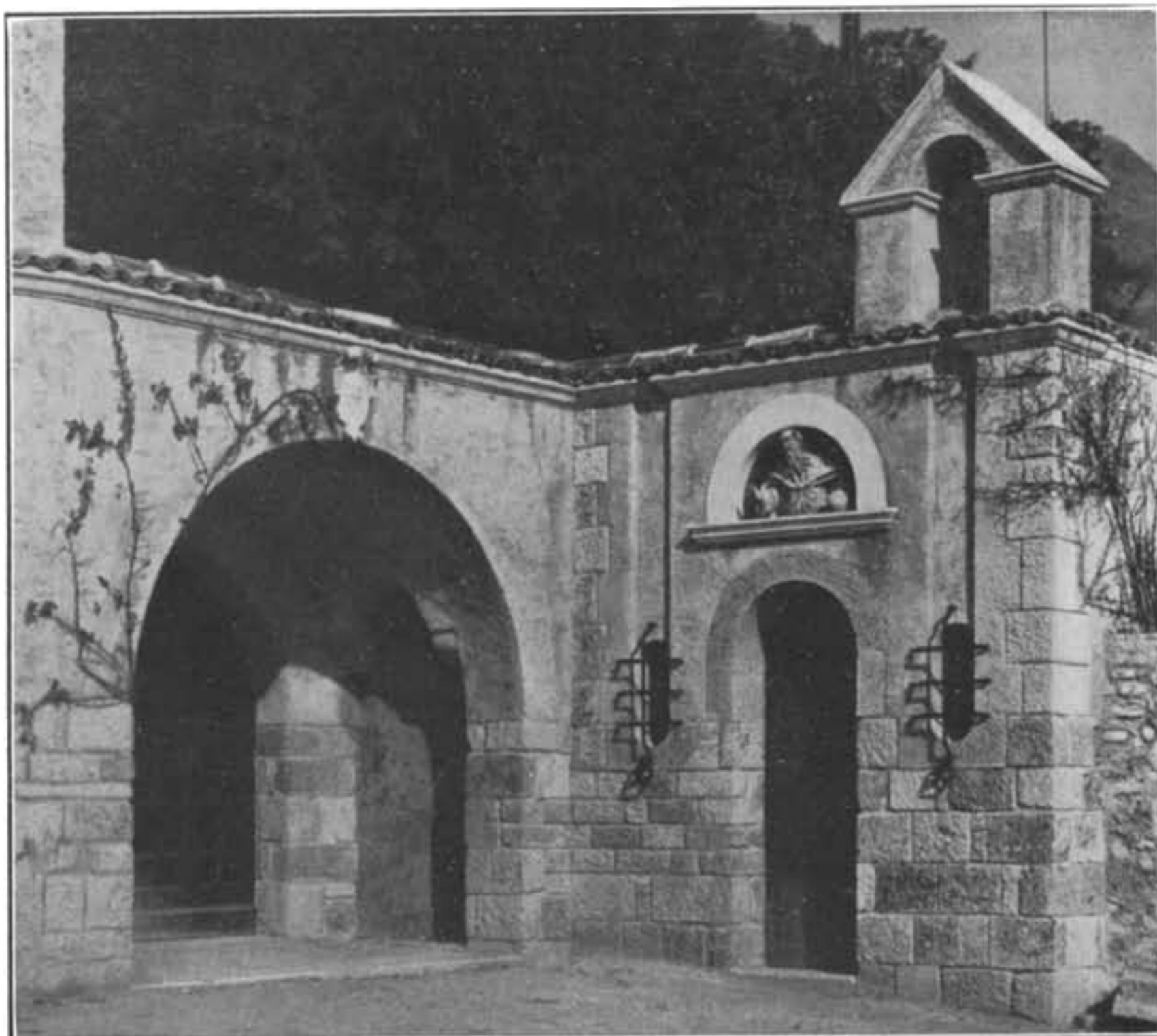
DETTAGLIO DEL MURO DI CINTA.
