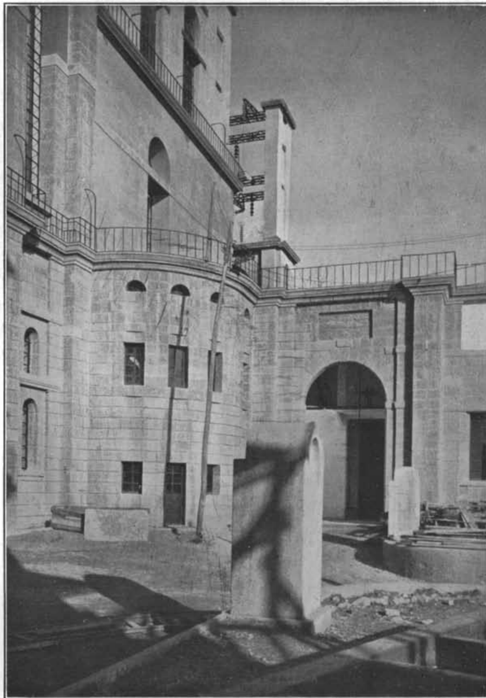
DETTAGLIO DELLA CENTRALE IDROELETTRICA DEL PONALE.
