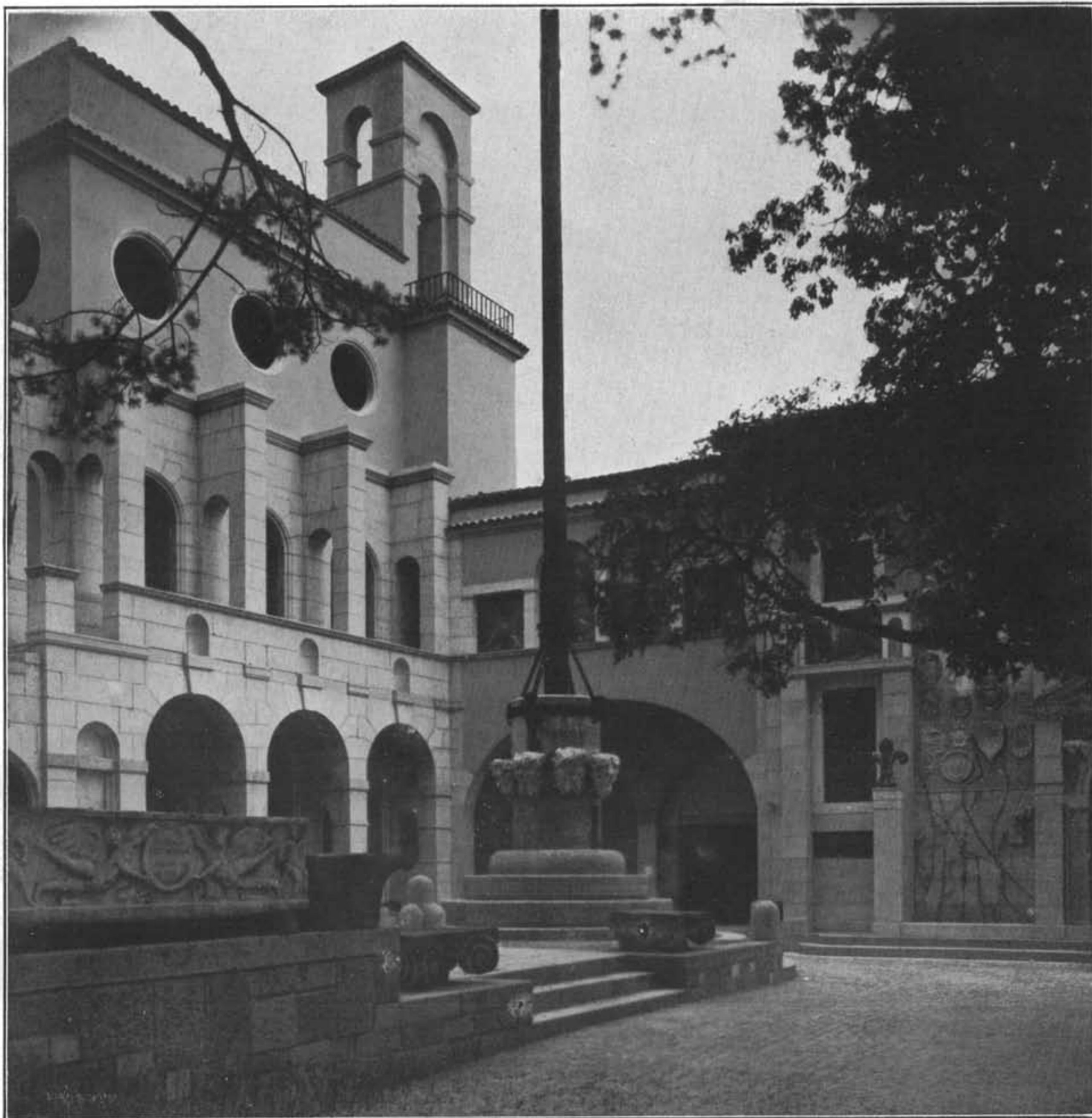
ARCH. GIAN CARLO MARONI: IL VITTORIALE. GLI EDIFICI CIRCOSTANTI LA PIAZZETTA DELLO SCHIFAMONDO.
