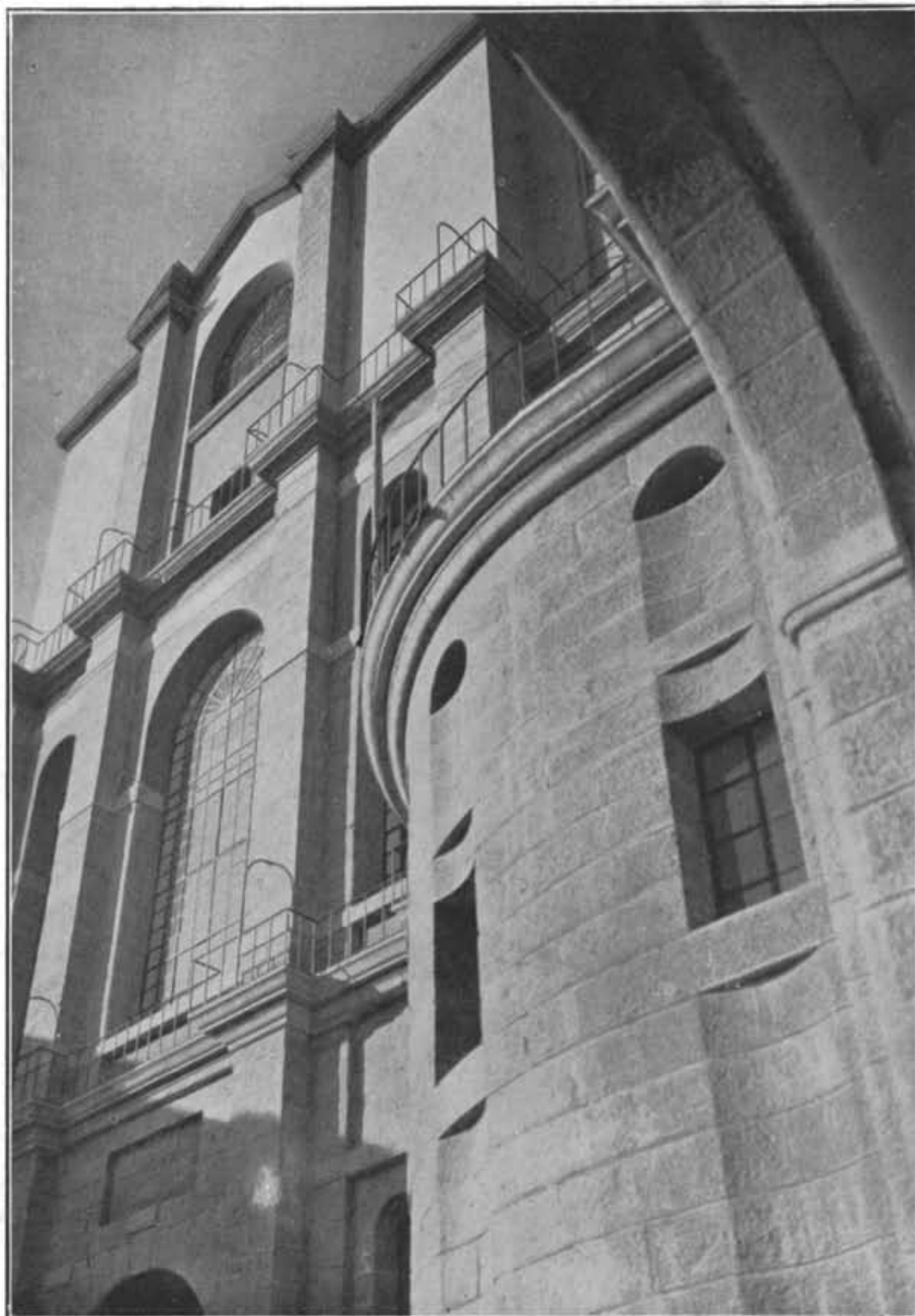
ARCH. GIAN CARLO MARONI: CENTRALE IDROELETTRICA DEL PONALE PRESSO RIVA SUL GARDA. - DETTAGLIO.
