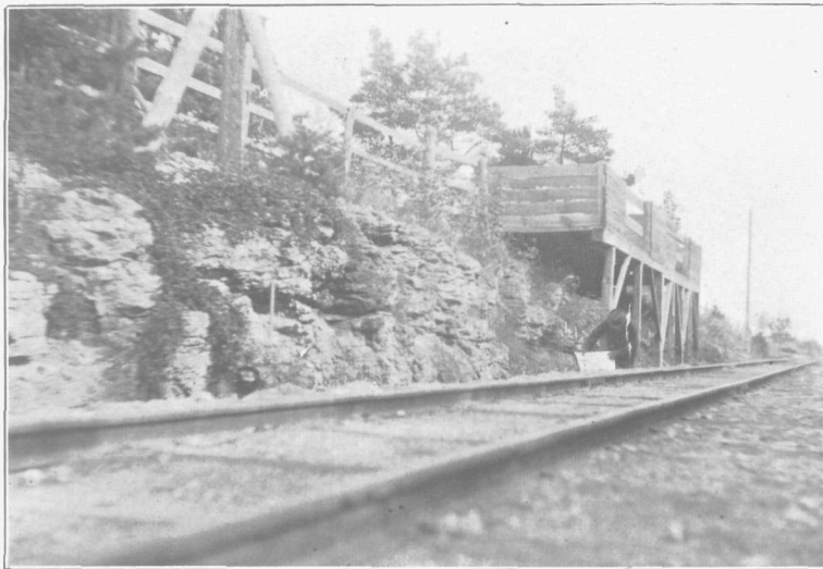
Spoorweg-insnijding bij Stor Vede. Stor Vede-kalk, duidelijk naar het Z.O. hellend. (De spoorweg is horizontaal).
