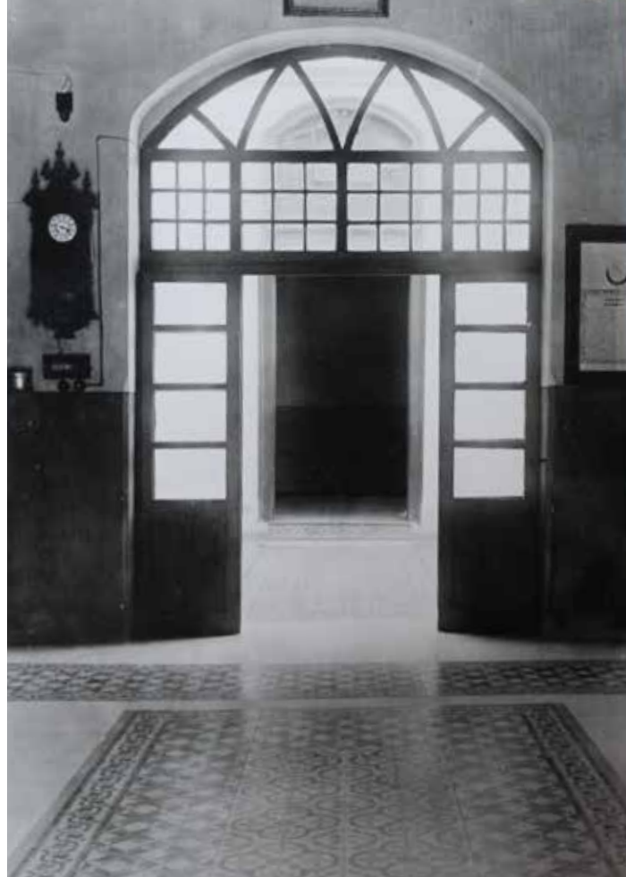
Yıkılan taş binanın giriş kapısı
