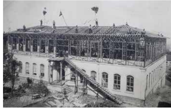
Taş binanın çatı onarımı, 1920'ler
