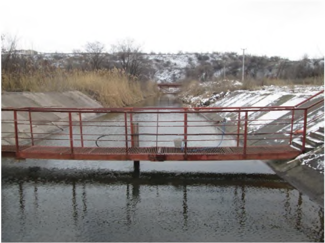
Фото 7.1. Обвідний канал обладнаний датчиками відбору проб ПАТ “АрселорМіттал Кривий Ріг”
