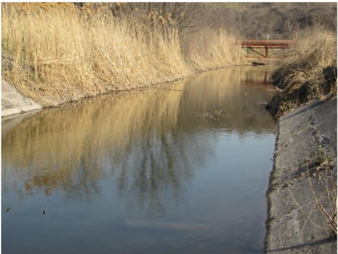
Фото 7.2. Обвідний канал ПАТ “АрселорМіттал Кривий Ріг”
